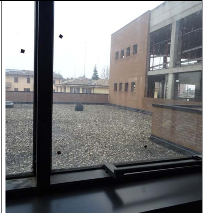
Vista terrazza adiacente piano secondo
