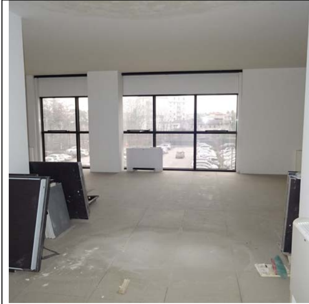
Interno piano secondo sub 8
