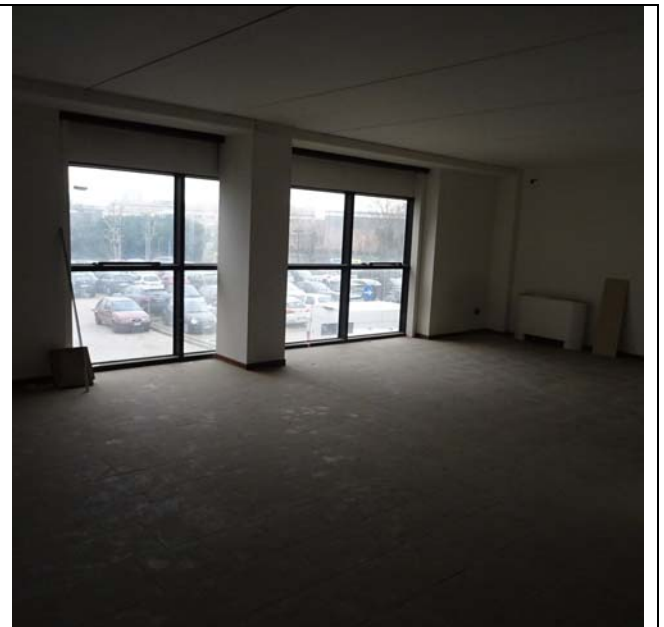
Interno piano primo
