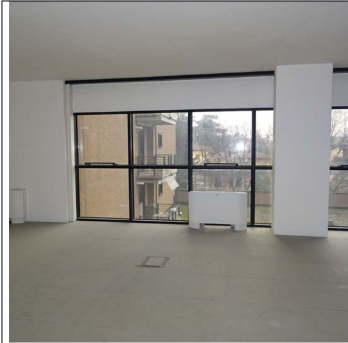
Interno piano terzo sub 10
