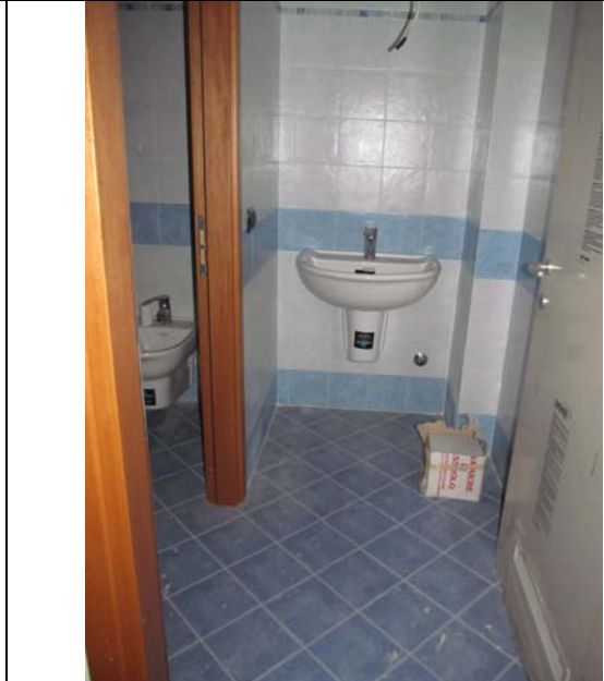
Interno piano secondo sub 8
