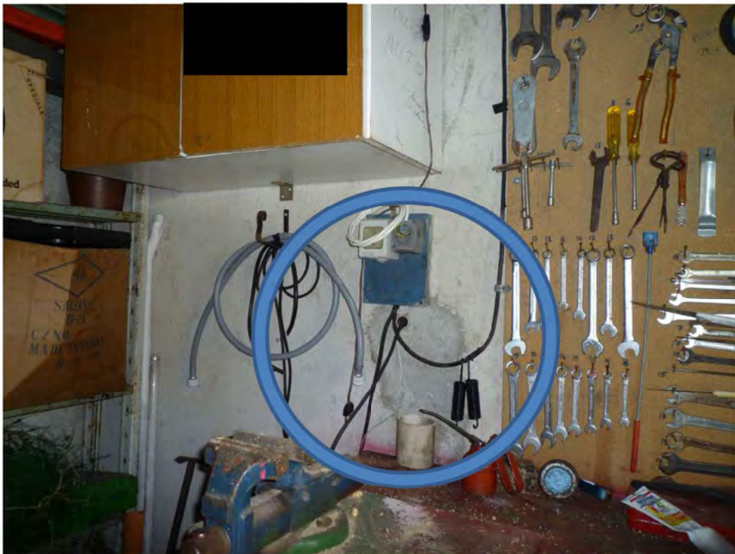
FOTO 55-56 locale accessorio 1 particolari di finestra murata e filo elettrico
