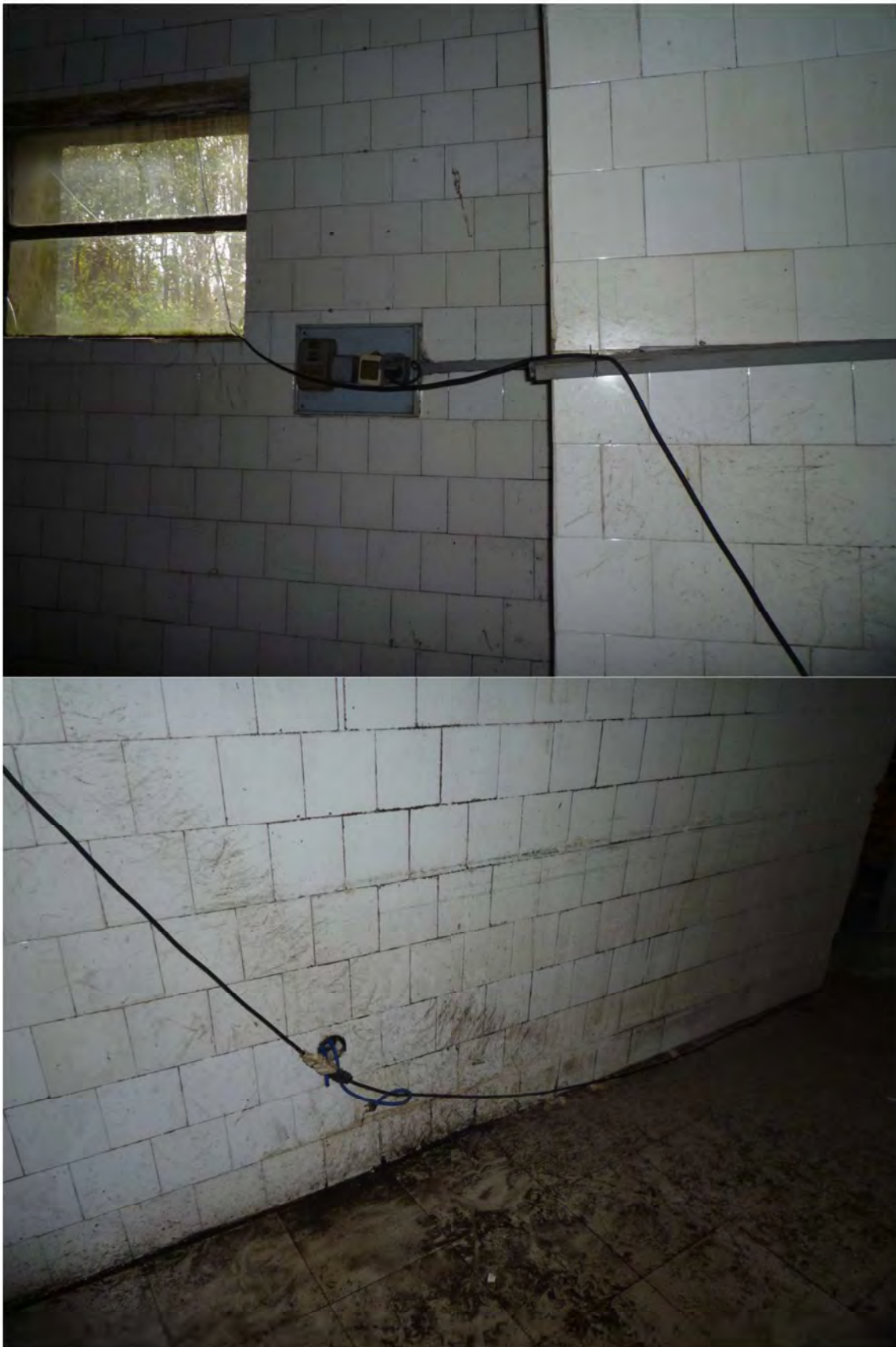
FOTO 30-31 fili elettrici aerei sala lavorazione 3
