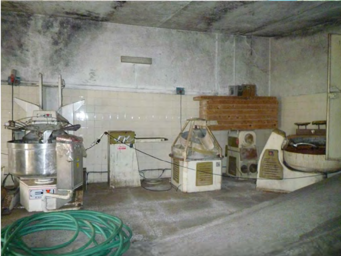
FOTO 42-43 macchinari sala lavorazione 4 traccia filo elettrico aereo
