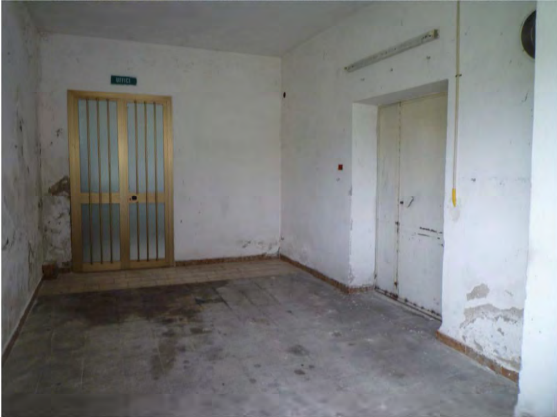
FOTO 49-50 portico e linea di confine su strada comunale
