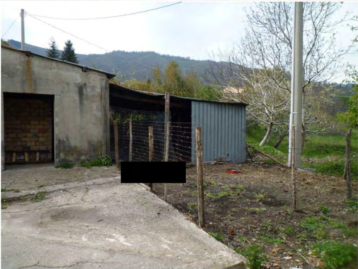
FOTO 46-47-48 retro forni e pollaio
