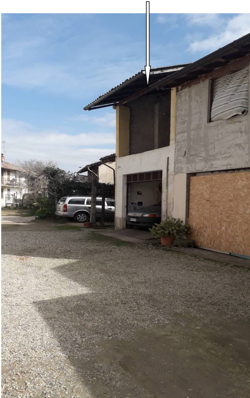
Autorimessa con cassero soprastante
