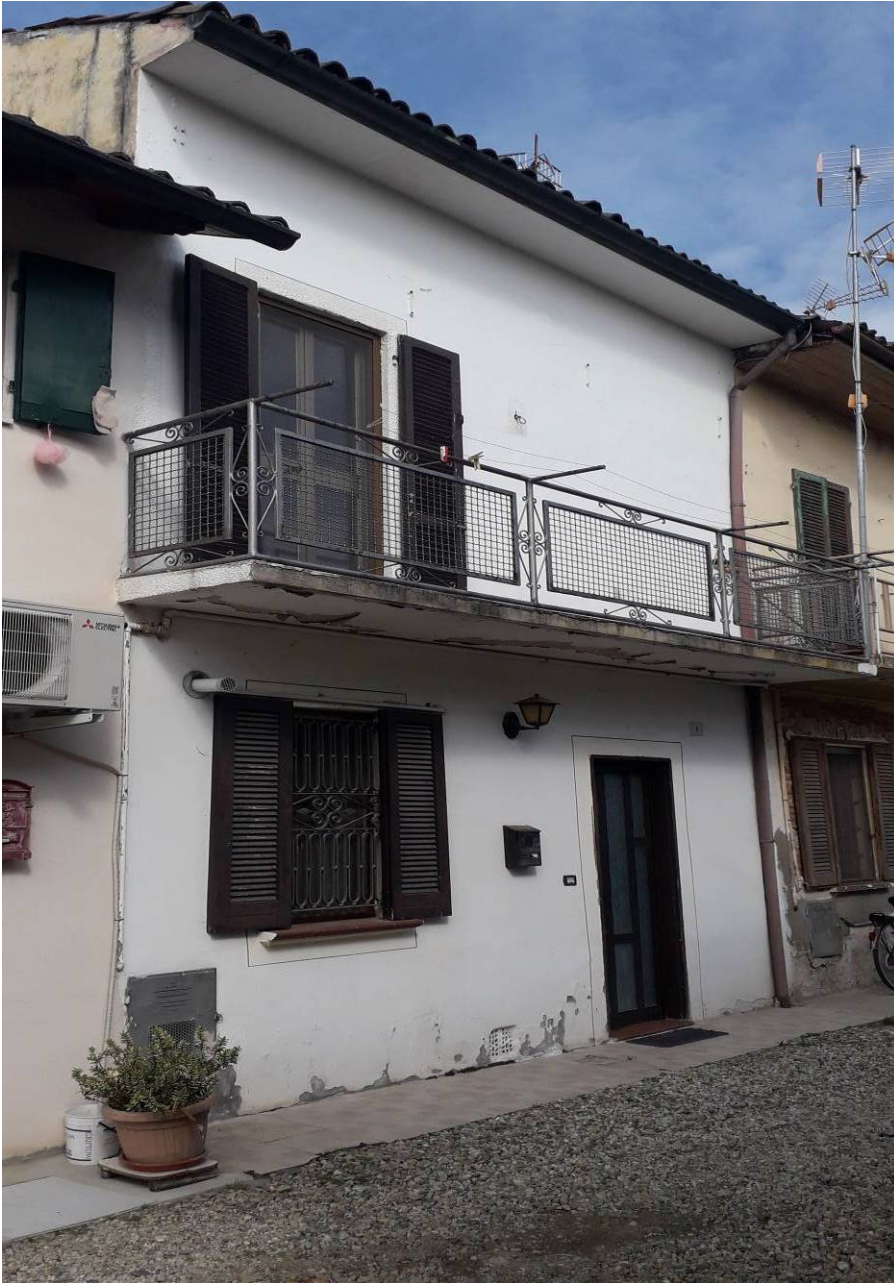
Abitazione via del Croix 2i
