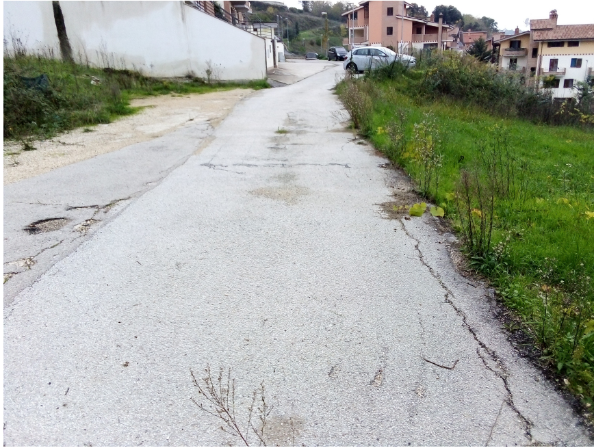
Foto 3: Strada per viabilità interna intersecante i due lotti
