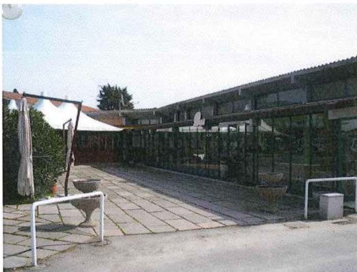
Piazzale oggetto dell'intervento sala multifunzionale
