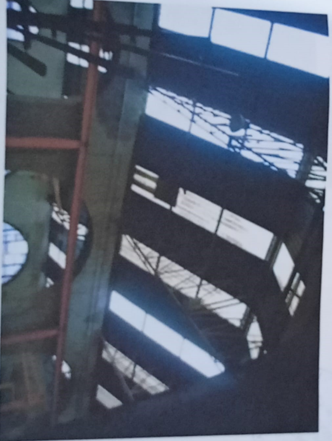
Foto n° 13 e 14 – secondo capannone con particolare sist. illuminazione naturale
