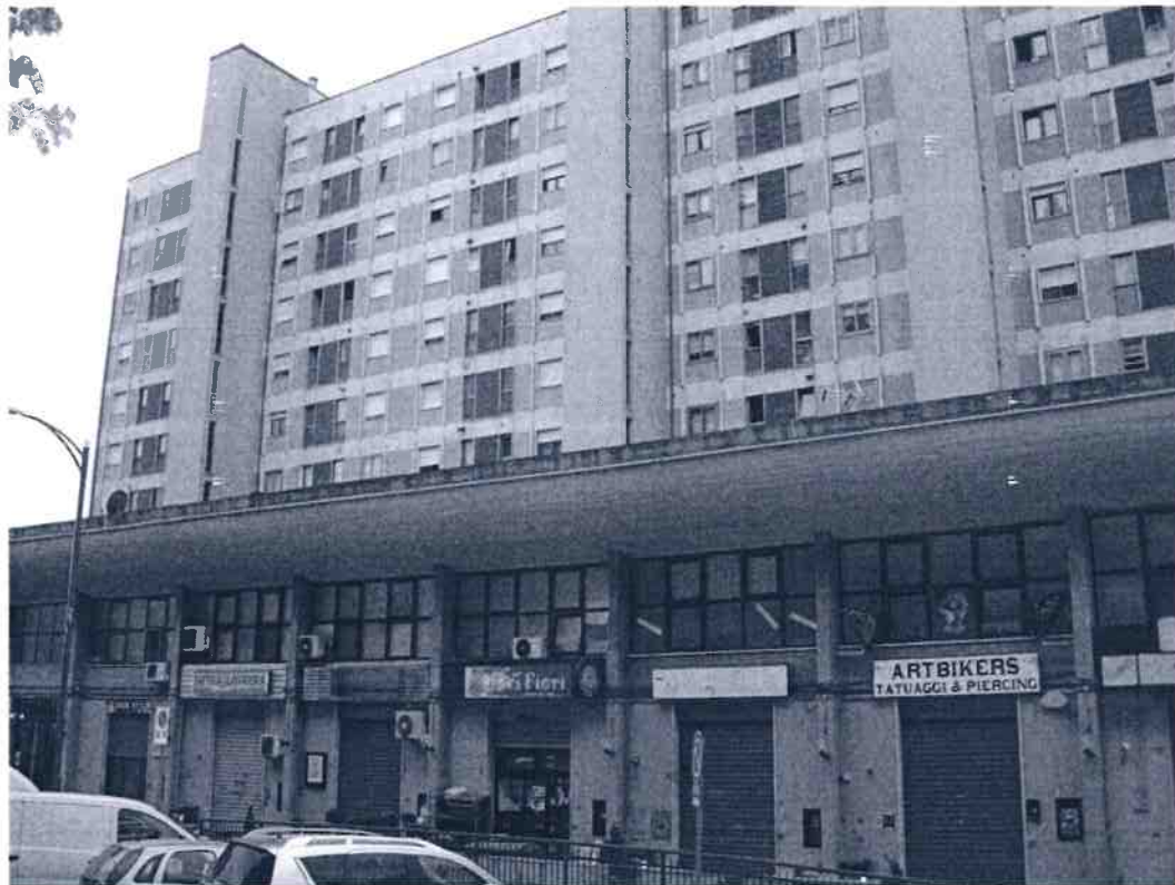
Ripresa fotografica del fabbricato sito in via Tirreno n. 43
