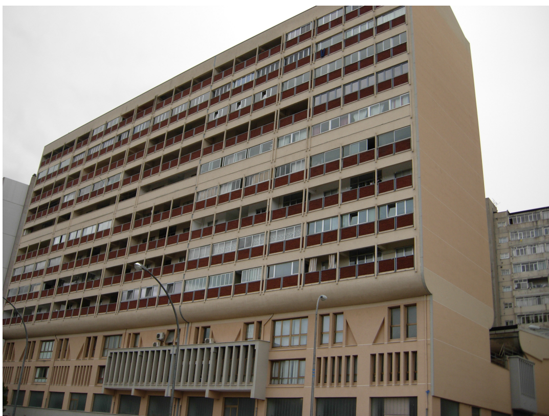
Foto 1 - 2 – Vedute panoramiche del fabbricato in cui è ubicato l'immobile pignorato
