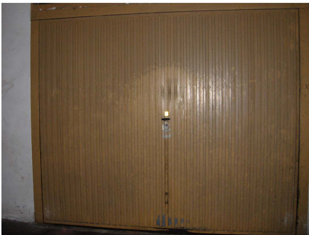
Foto 14 – Serranda basculante di accesso al garage
