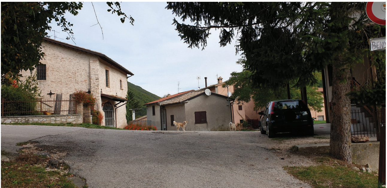
Foto n° 3: fabbricati posti nella frazione Spina vecchia in prossimità delle unità immobiliari oggetto di stima
