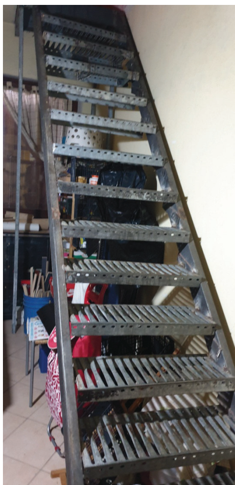
Foto n° 14: scala interna in ferro che conduce al piano soffitta
