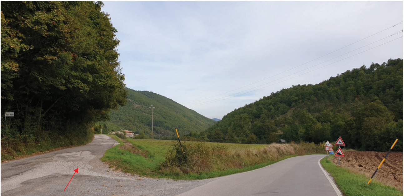
Foto n° 2: strada di accesso dalla strada provinciale 459 alla Frazione di Spina Vecchia
