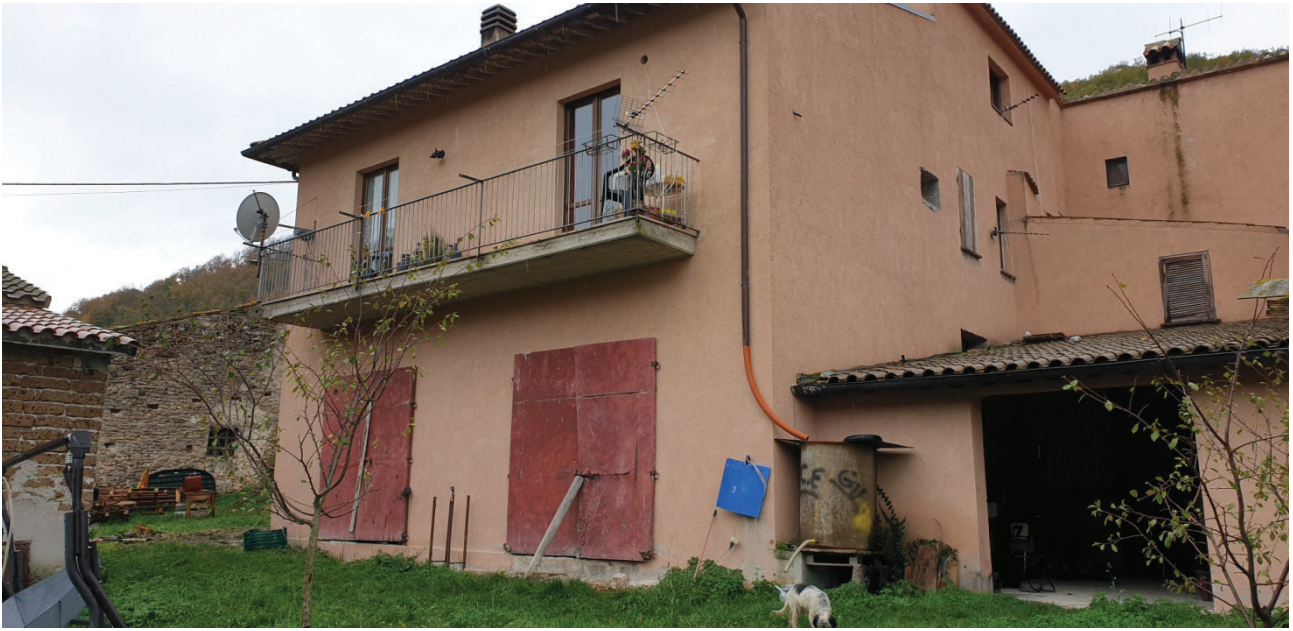
Foto n° 6: lato nord/est del fabbricato ove si trovano le unità immobiliari in oggetto
