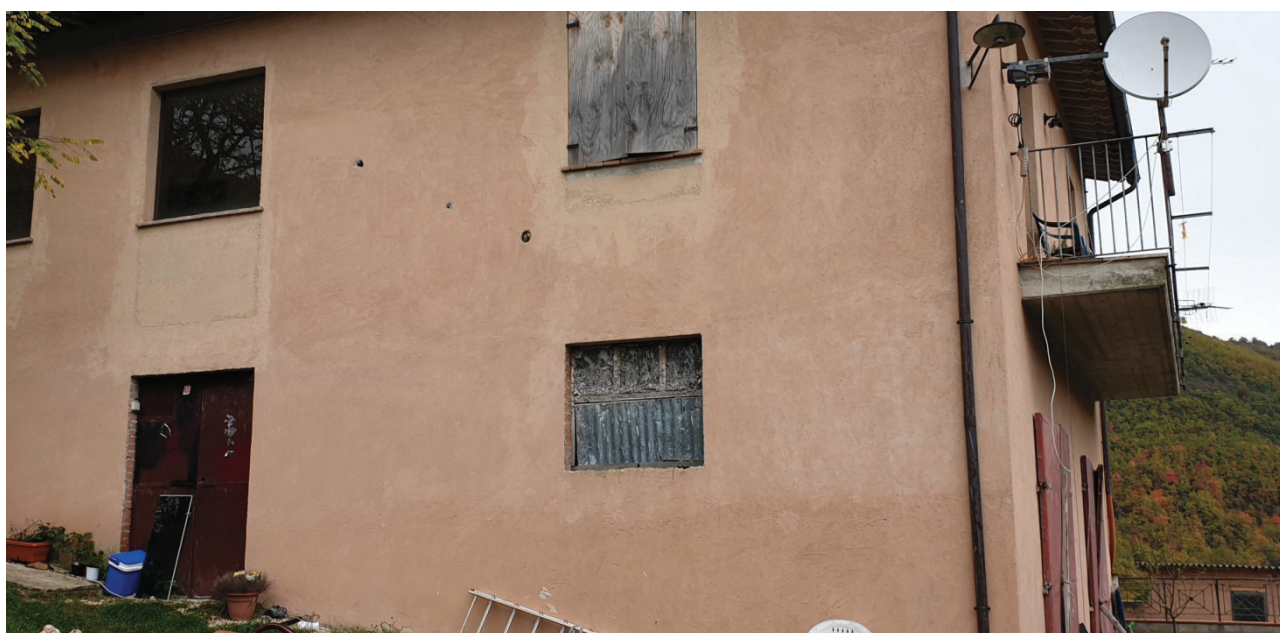
Foto n° 5: lato sud del fabbricato ove si trovano le unità immobiliari in oggetto
