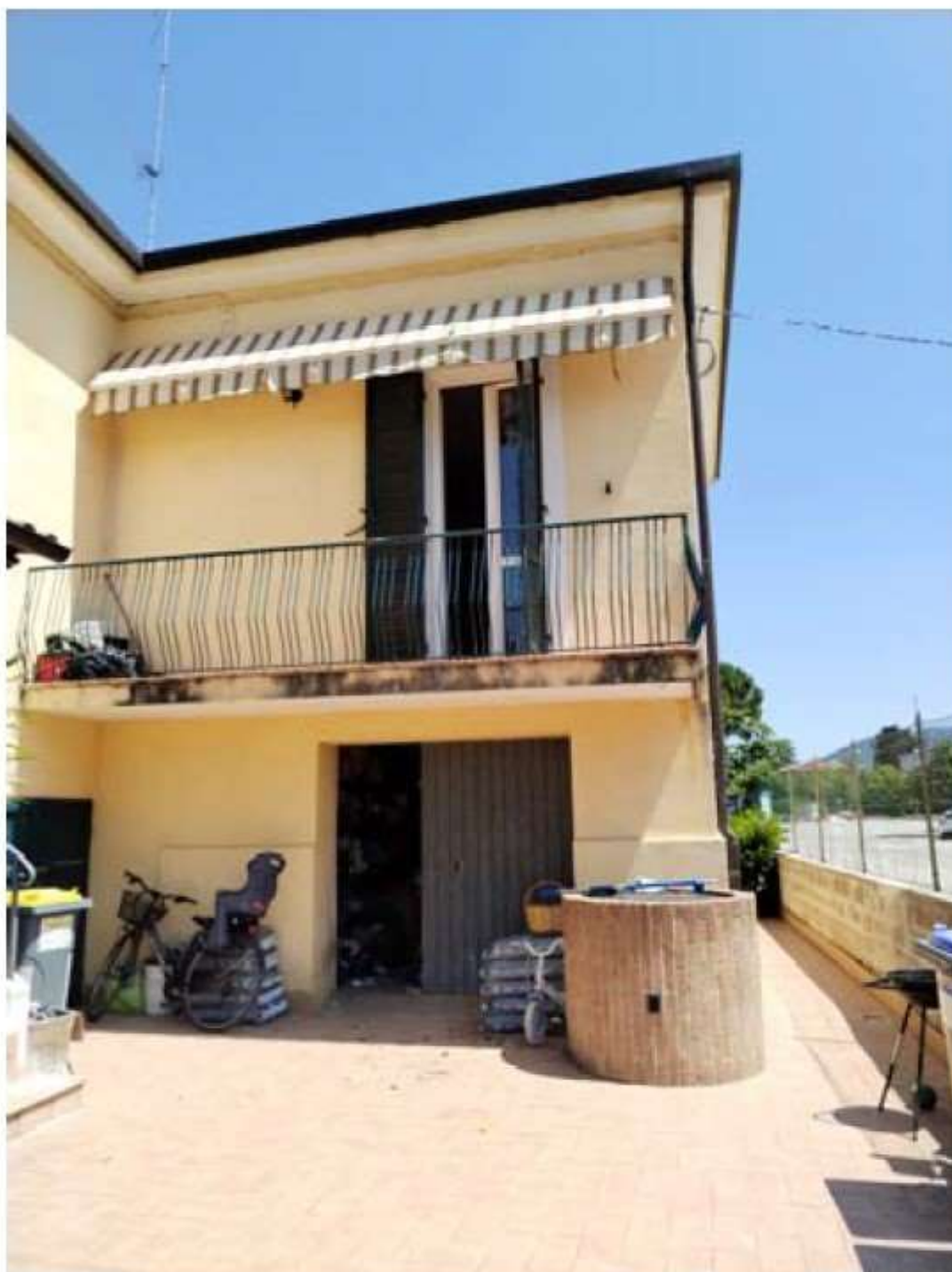
Balcone sul prospetto sud-ovest
