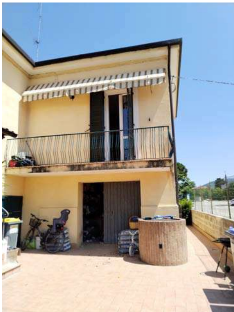
Balcone sul prospetto sud-ovest
