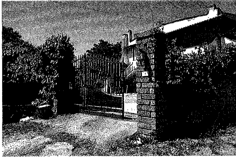
foto n.3- Cannello carrabile-pedonale esposizione Sud
