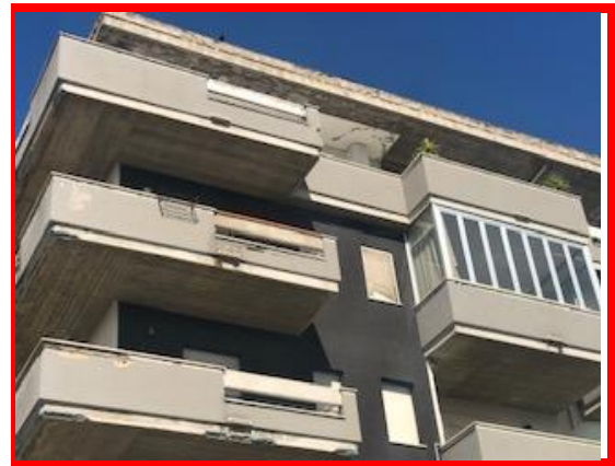
Foto 2 – Panoramica quarto piano con veranda chiusa.
