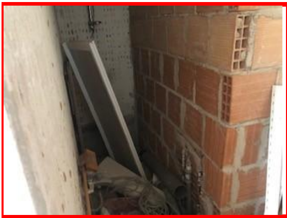
Foto 15 – Attività edile di realizzazione locale servizi igienici.
