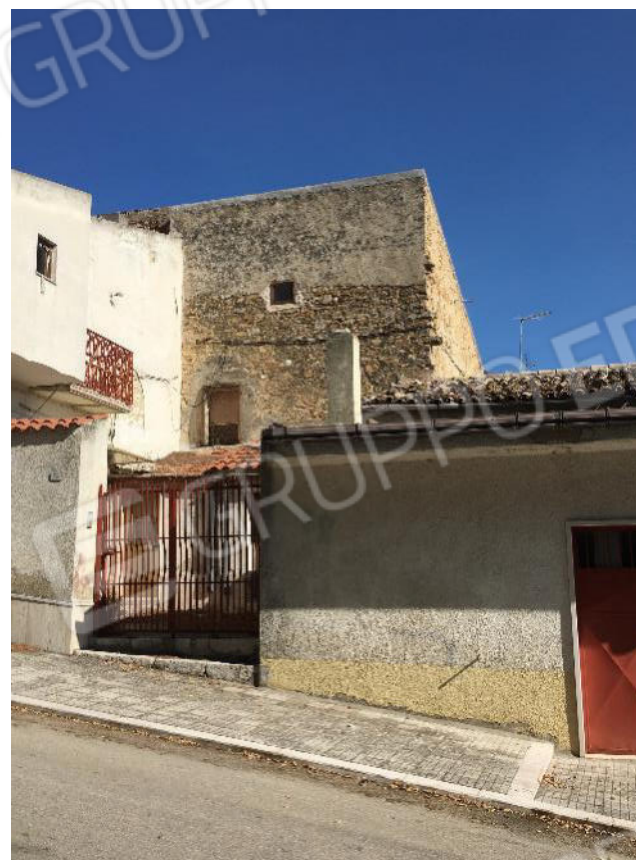
2. Esterno, lato ovest retrostante ingresso.
