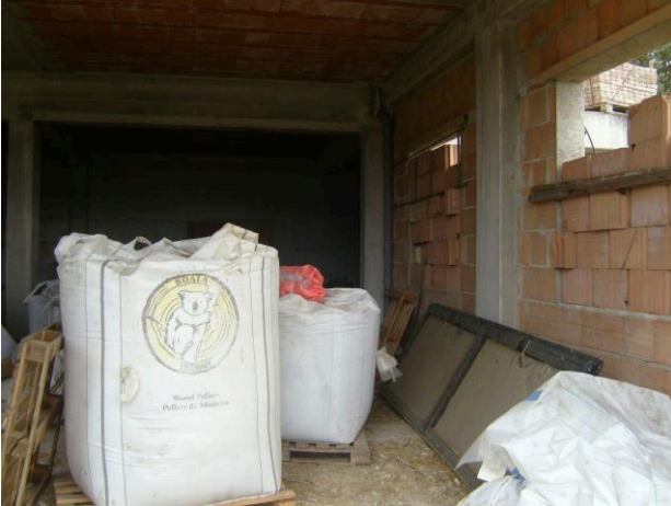
Foto interna piano seminterrato (deposito part. 880)
