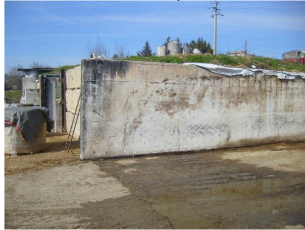
Foto esterna silos orizzontali part.IIa n. 882
