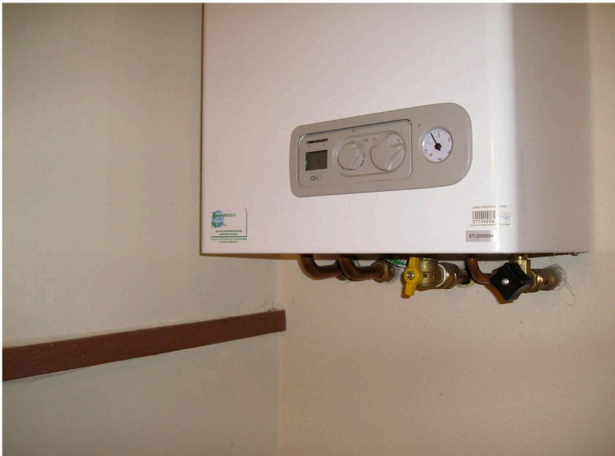
Foto 12 Abitazione Sub.19 - Particolare Caldaia Murale
