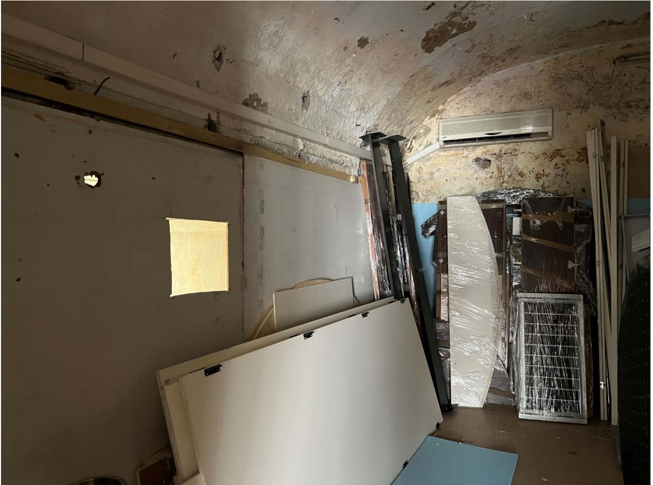
Foto 6 – Vista della parte posteriore del locale (ambiente originario)
