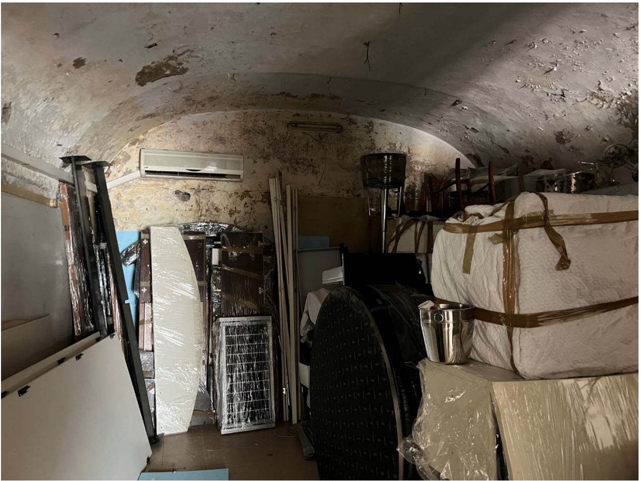
Foto 7 – Vista della parte posteriore del locale (ambiente originario)
