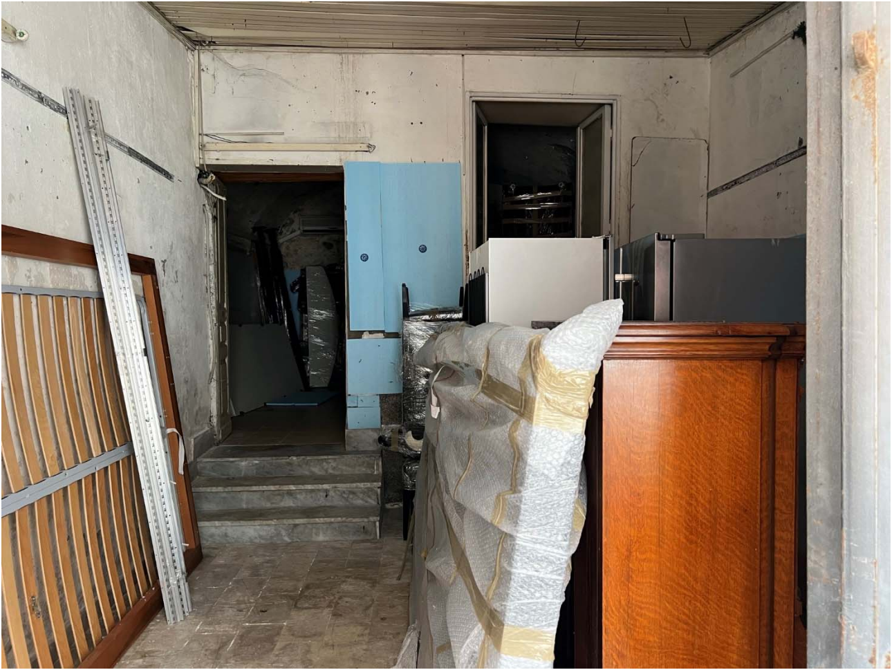
Foto 3 – Vista della parte anteriore del locale (cortiletto coperto) e dell'accesso a quella posteriore
