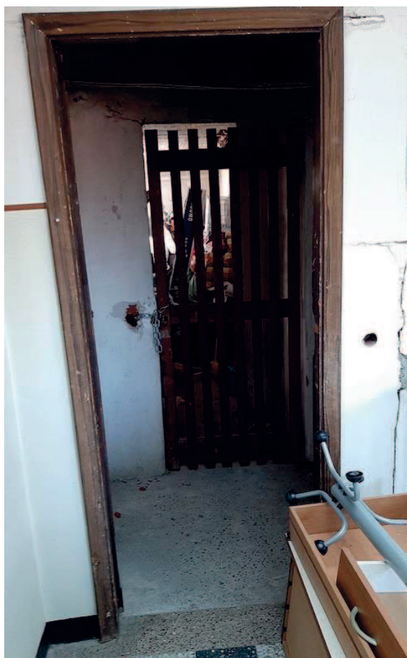
il ripostiglio al piano sottotetto
