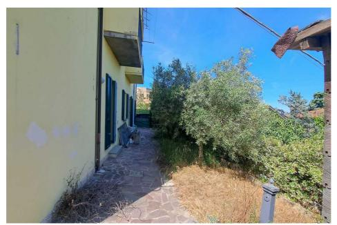
Il fabbricato, costruito ante 1967, ha struttura portante verticale in muratura ed è provvisto di copertura inclinata a padiglione con manto in tegole marsigliesi e canali di gronda e tubi pluviali lamiera zincata verniciata.
