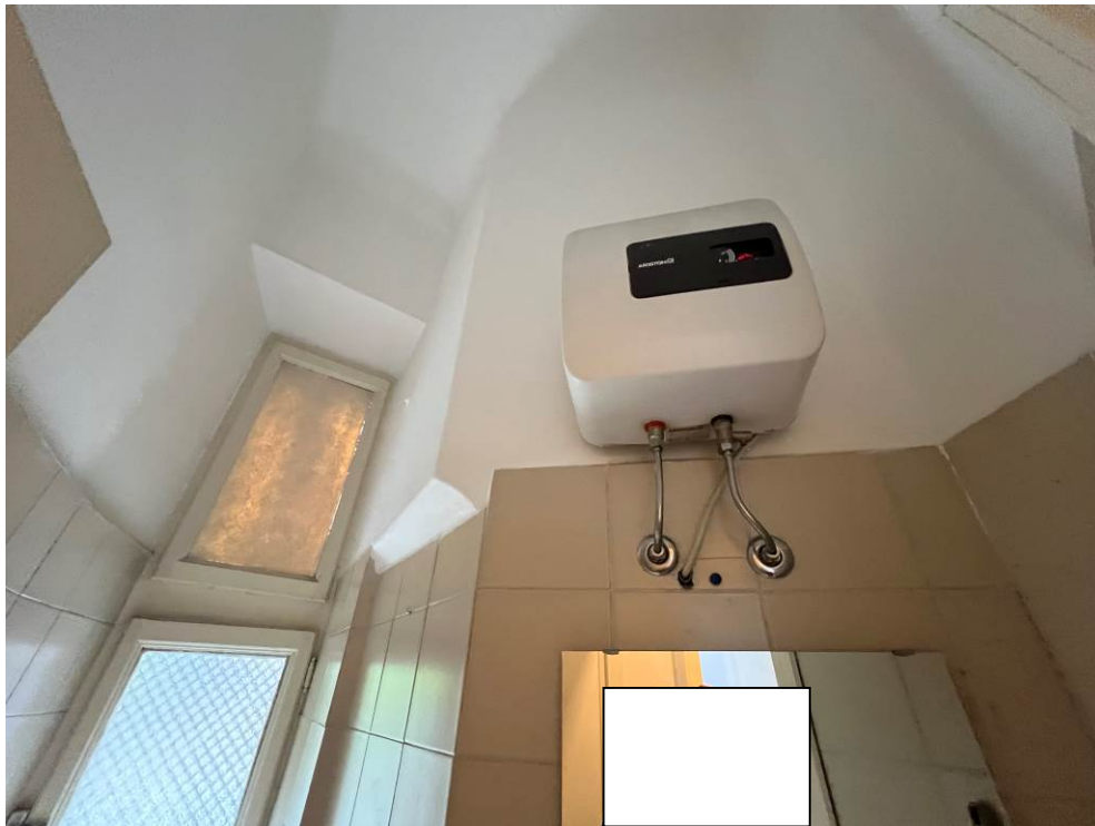
Fotografie n. 18/19 – Viste del locale bagno, con particolare del boiler elettrico
