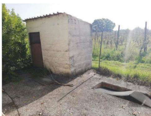
foto 52: ...manufatto depuratore sulla p.lla 57
