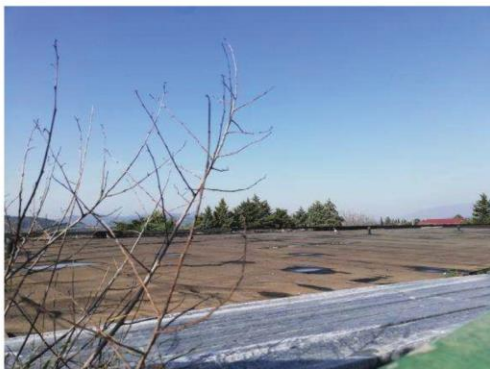
foto 41: ... stato della copertura
