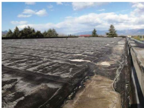
foto 53: ... stato della copertura
