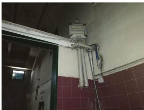
foto 40: ... aerotermini in reparto produzione
