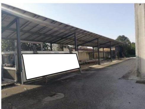
foto 43: ... Pensilina con fotovoltaico
