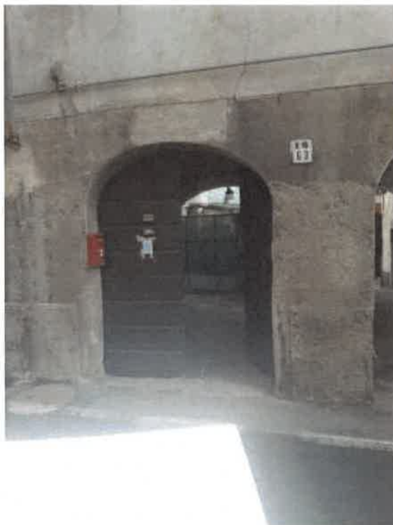
Vista dalla strada pubblica dell'andito di accesso al cortile di accesso comune
