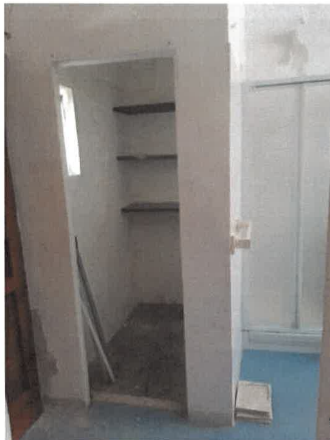
Visa interna del piccolo locale ripostiglio pertinenziale
