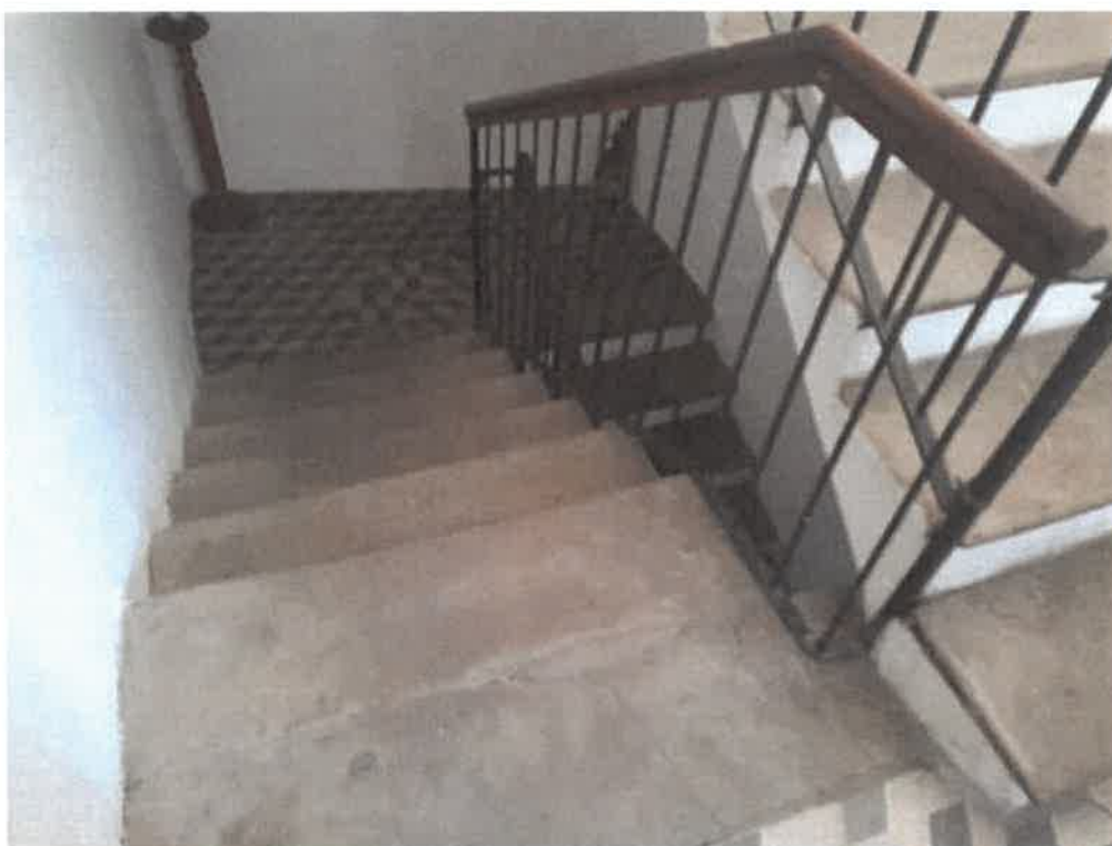
Vista interna del vano scala comune di accesso ai piani
