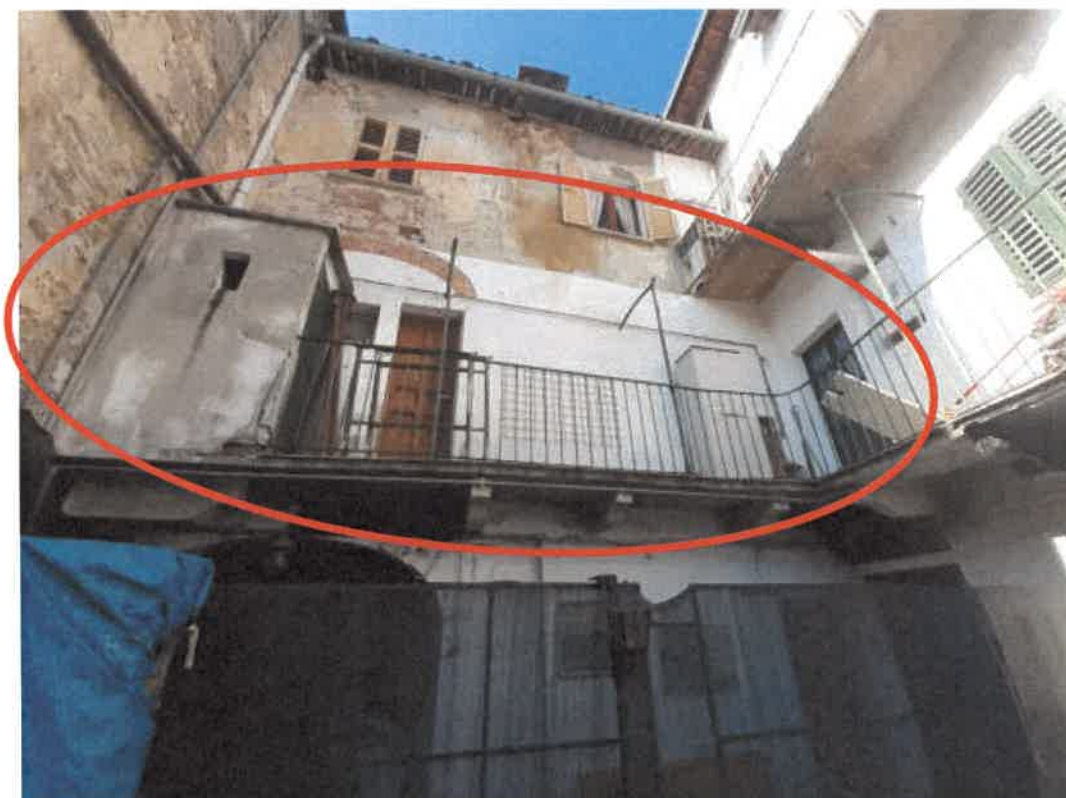
Vista del balconcino e piccolo locale ripostiglio esterni pertinenziali alla U.I.U.
