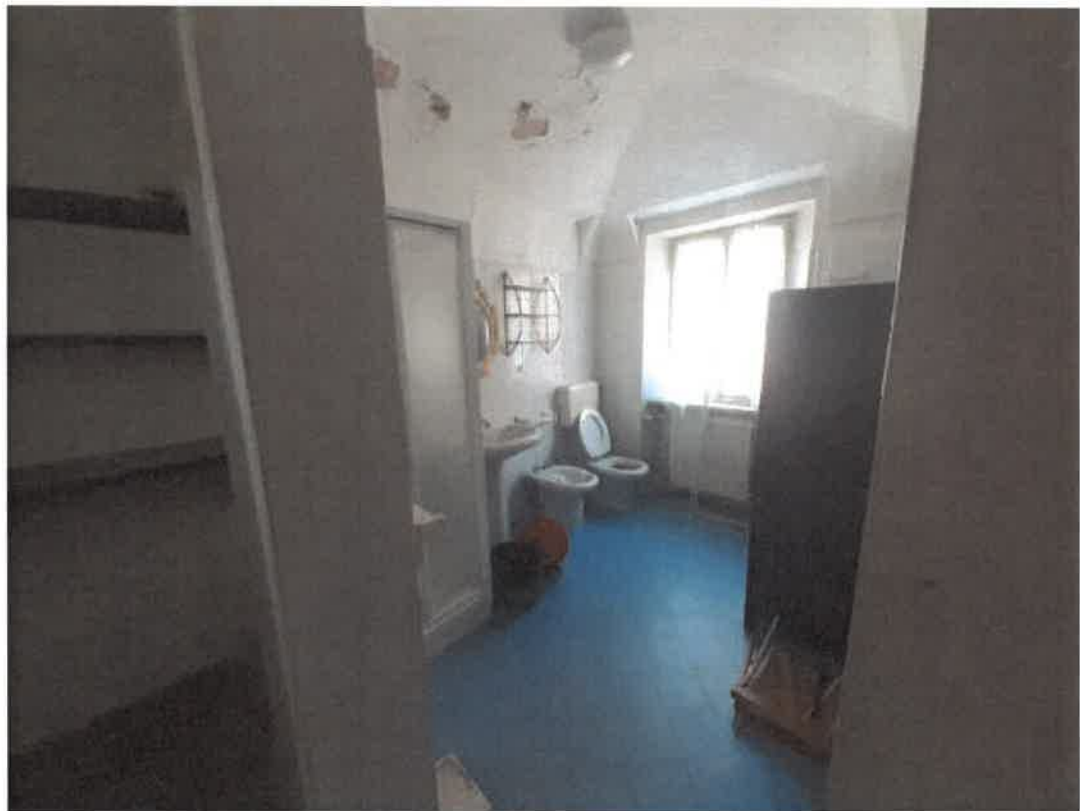
Vista interna del locale bagno pertinenziale ai vani di abitazione
