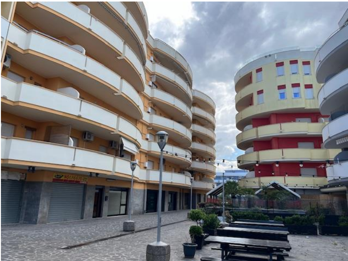
Vista da nord-est del fabbricato che include l'u.i.
