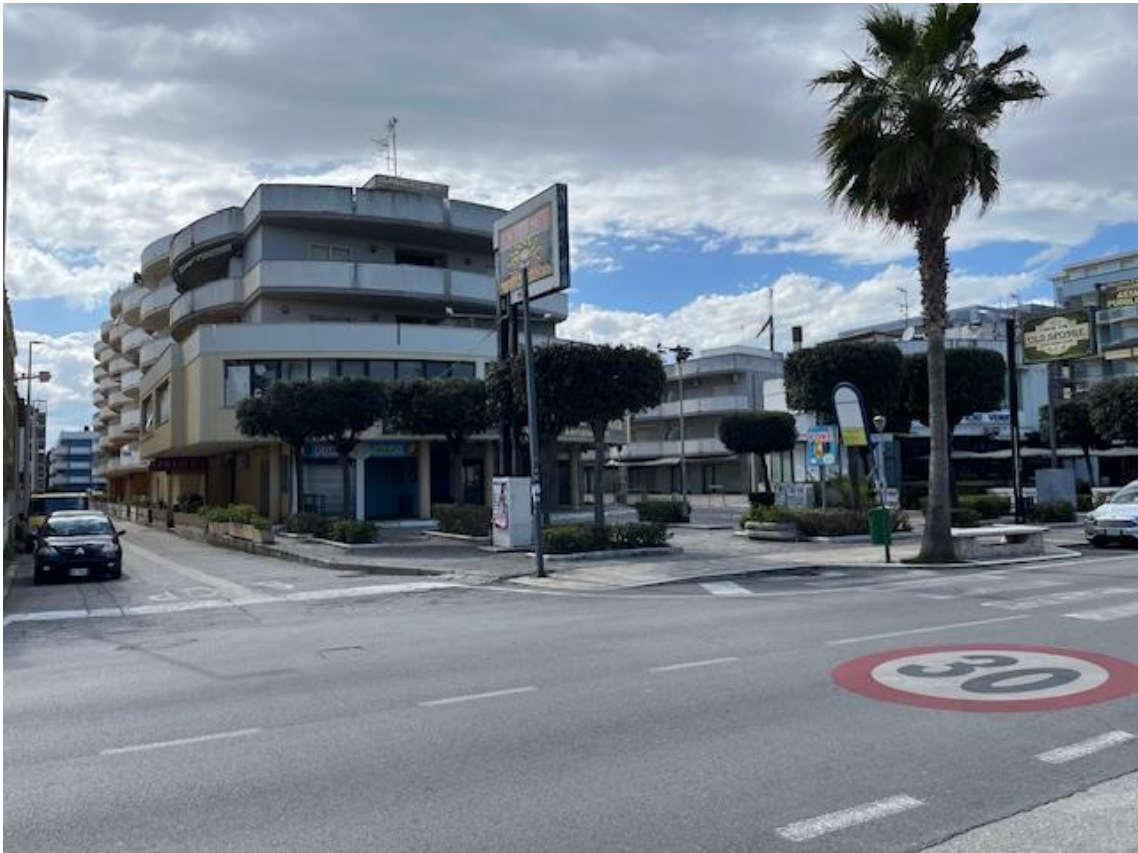
Vista dal lungomare del fabbricato che include l'u.i.
