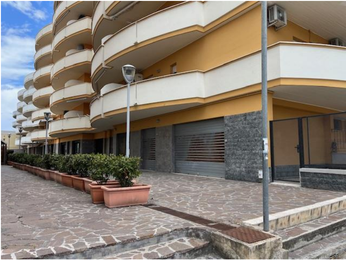
Vista da nord-ovest del fabbricato che include l'u.i.
