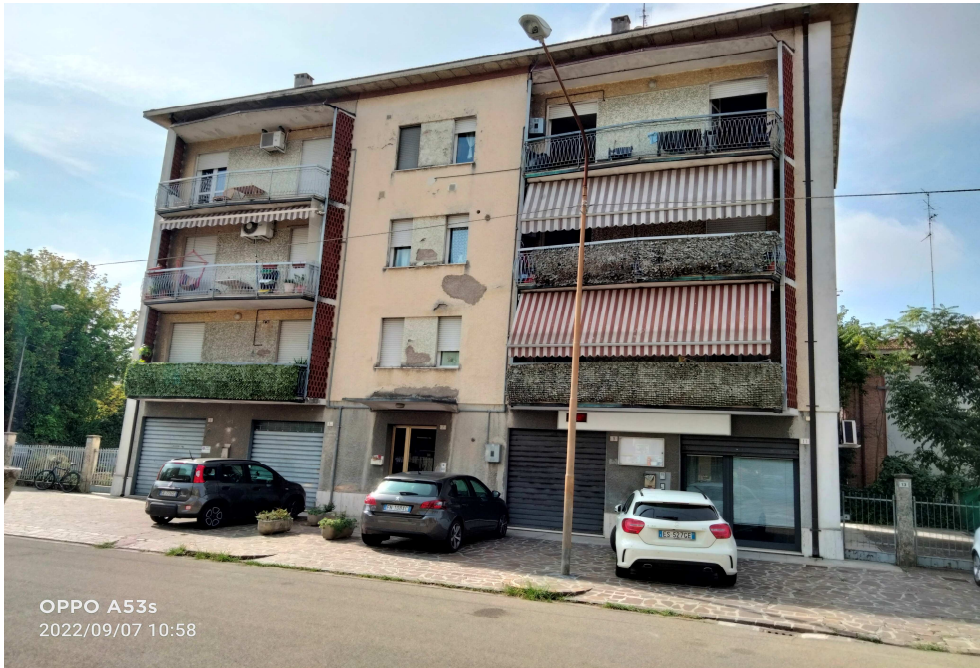
1. Vista fotografica prospetto su Via Abetone
