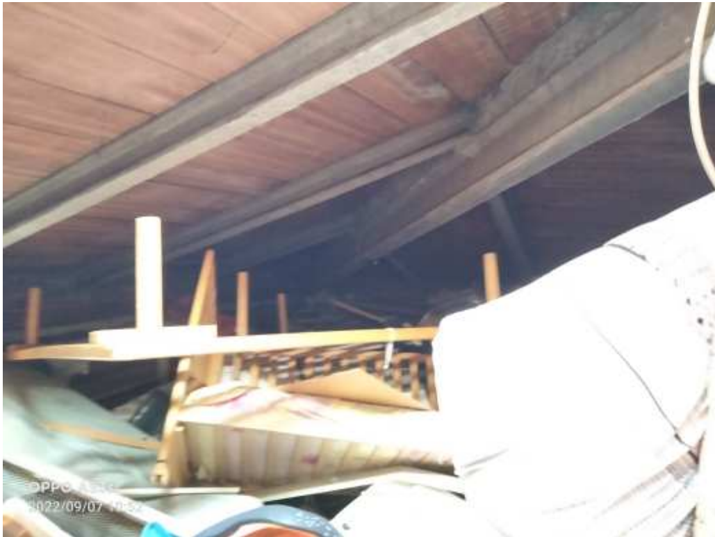
12. Vista fotografica soffitta
