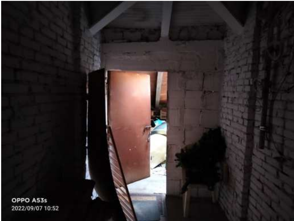
11. Vista fotografica soffitta
