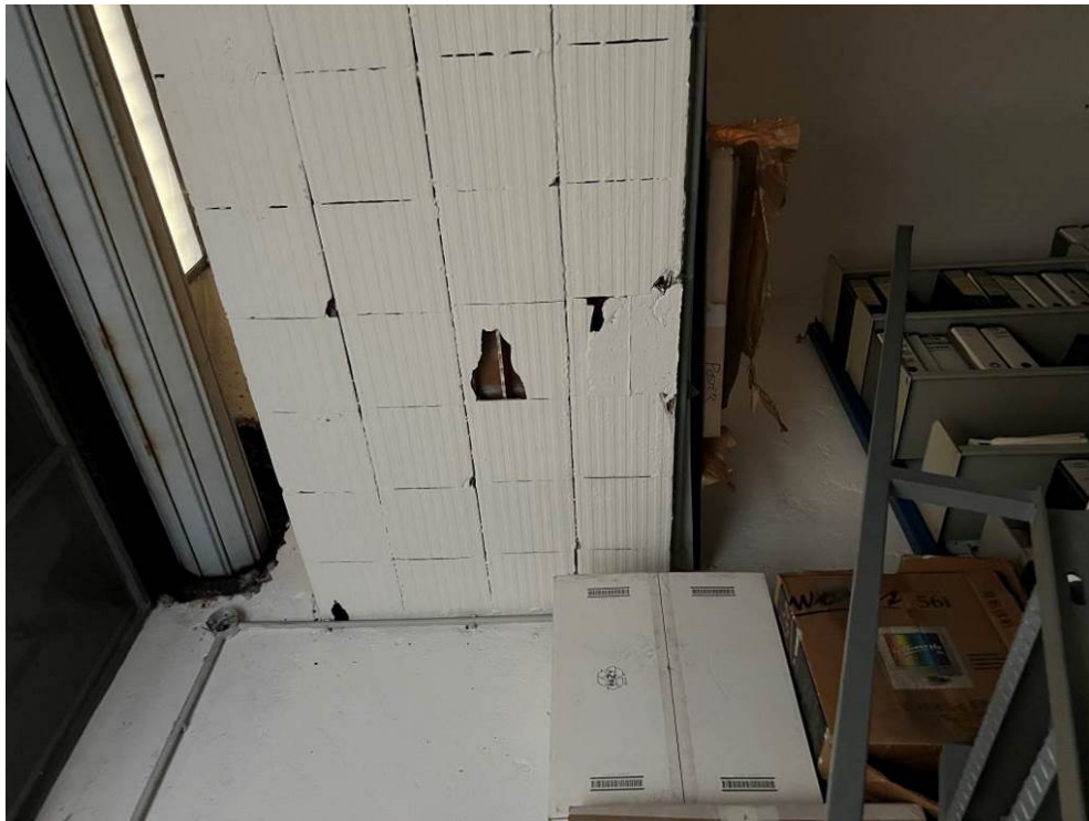
Fotografie n. 14/15 – Particolari del ripiano, in tavelle e ferro, posto sopra l'ingresso
