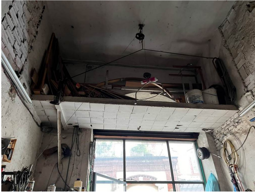
Fotografie n. 20/21 – Viste dell'interno del locale, con particolare del ripiano, in tavelle e ferri, posto sopra l'ingresso e della fossa di chiusura in ferro sul pavimento
