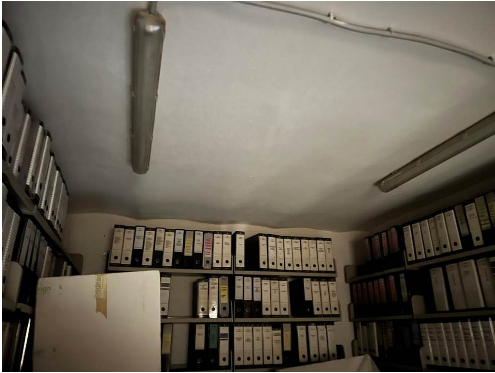
Fotografia n. 12 – Vista del locale soppalco
