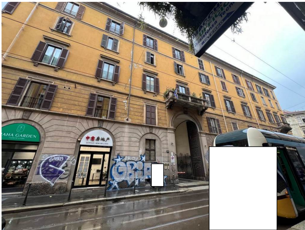
Fotografia n. 1 – Vista dell'accesso da Via Bramante n. 29 - Milano
