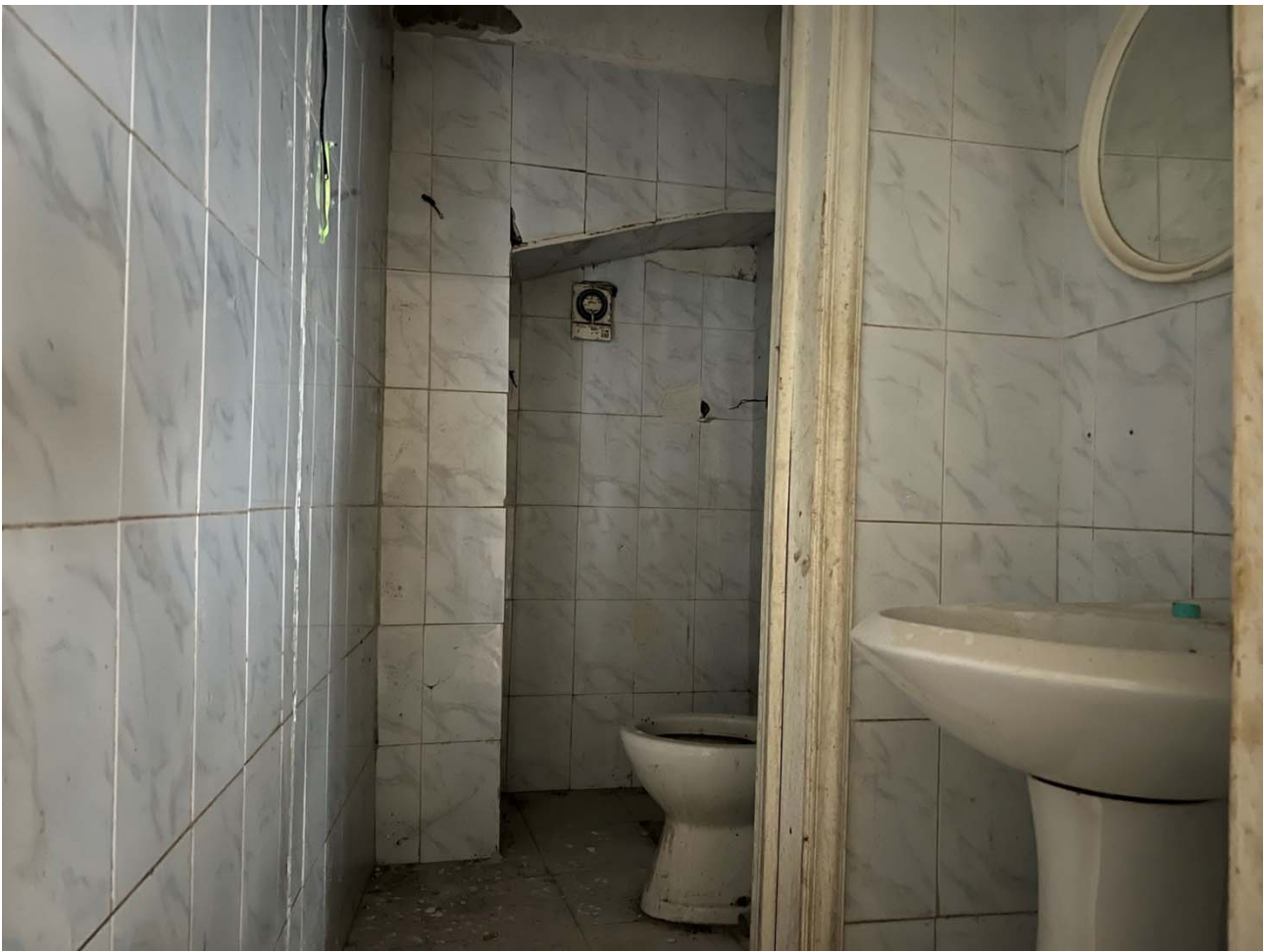
Foto 9 – Vista del bagno
