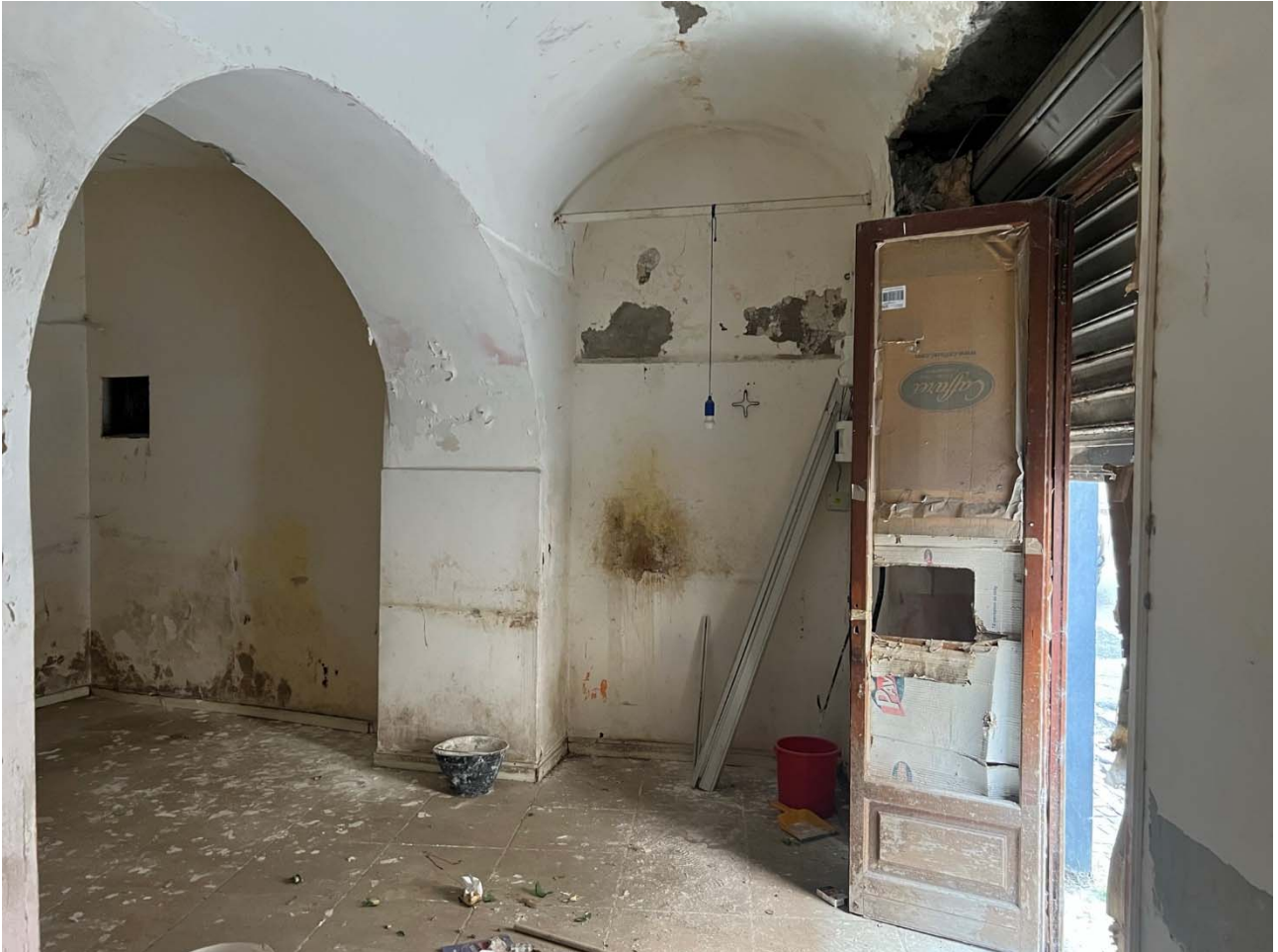
Foto 4 – Vista dell'ambiente anteriore del locale
