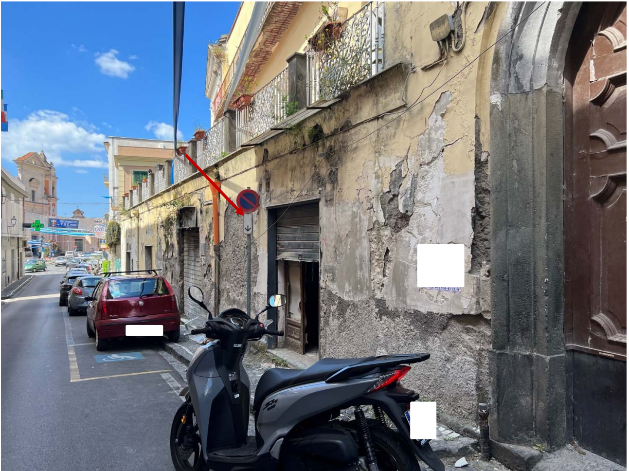
Foto 1 – Vista del dell'accesso al locale di via Carlo Alberto n. 82 – Boscotrecase (Na)
