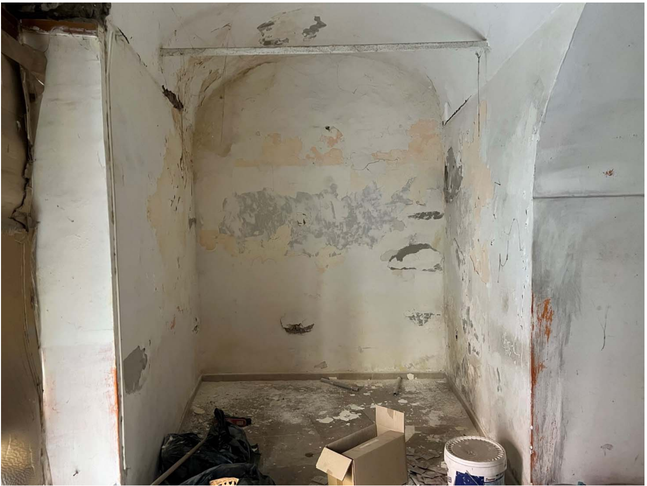
Foto 5 – Vista dell'ambiente anteriore del locale
