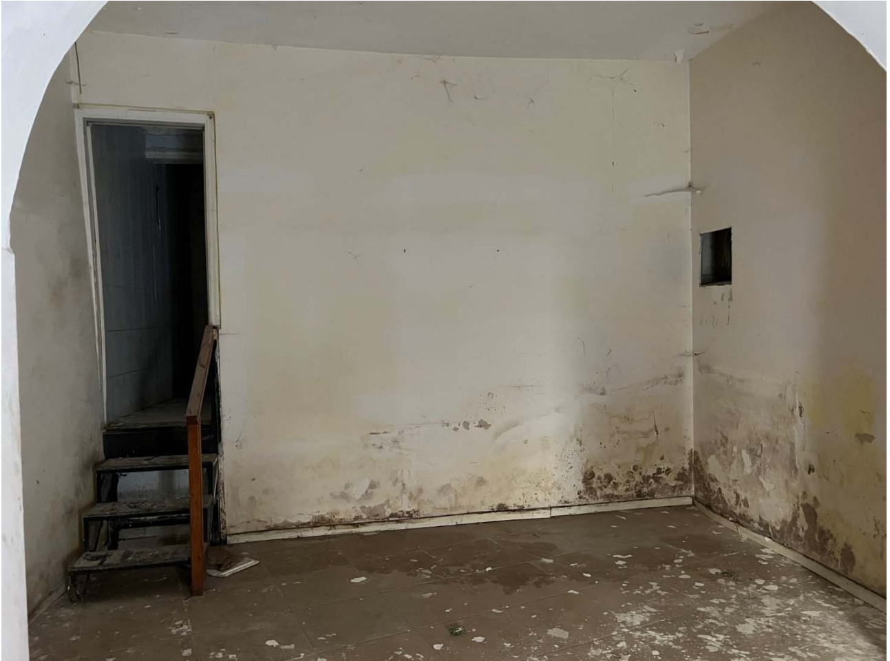
Foto 6 – Vista dell'ambiente posteriore del locale con accesso al piccolo bagno annesso
