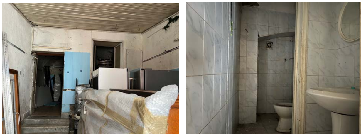
Vista della porzione anteriore del locale
