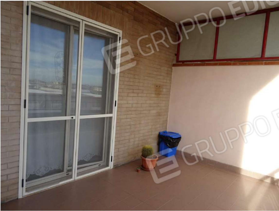
Loggia lato viale Cimitero
