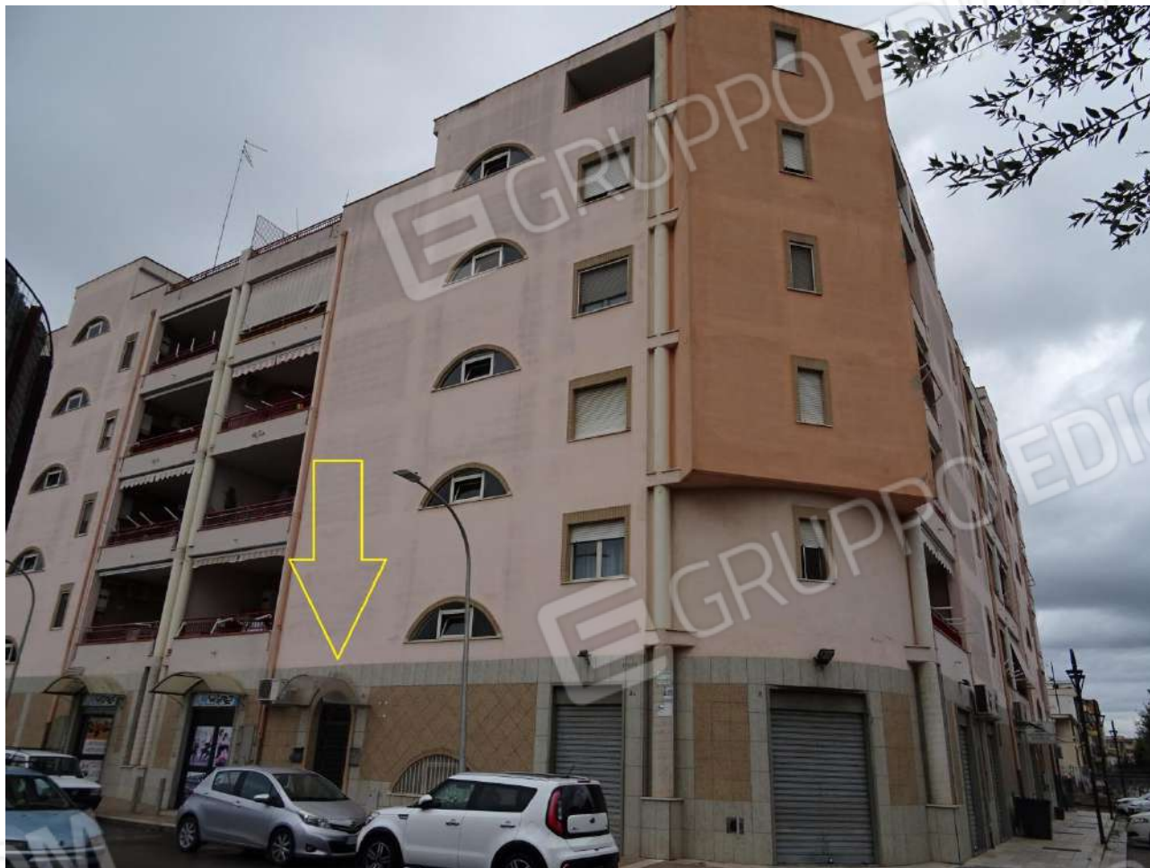
RILIEVO FOTOGRAFICO PRIMO SOPRALLUOGO – VIA ANAGNI N. 2/B CERIGNOLA (FG)
