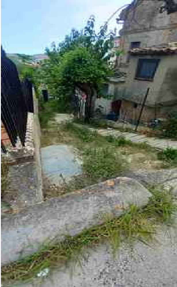
accesso e corte di pertinenza lato est
