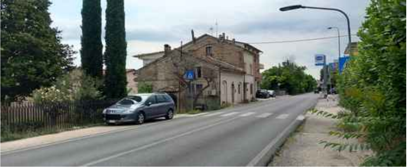
facciate nord e est del fabbricato – via Incancellata
