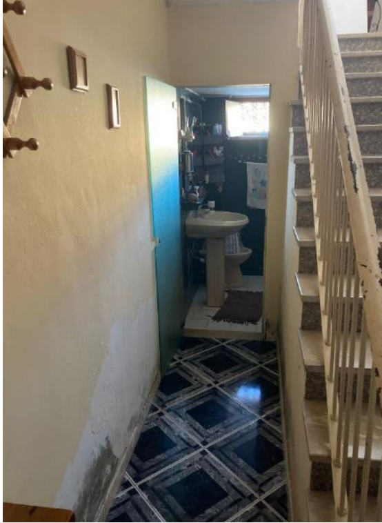
Piano terra - Vano scala
