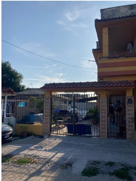
Accesso pedonale e carrabile all'immobile pignorato
