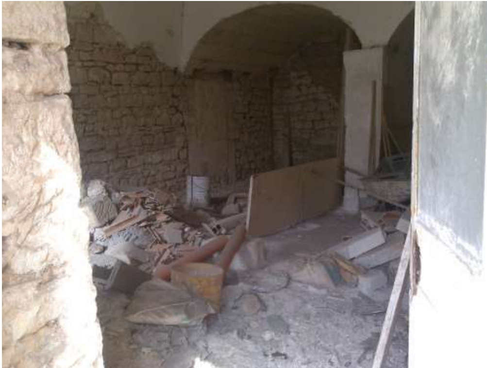
Particella 47 – Sub 2 - Foto n°4 - Vista interno locale
