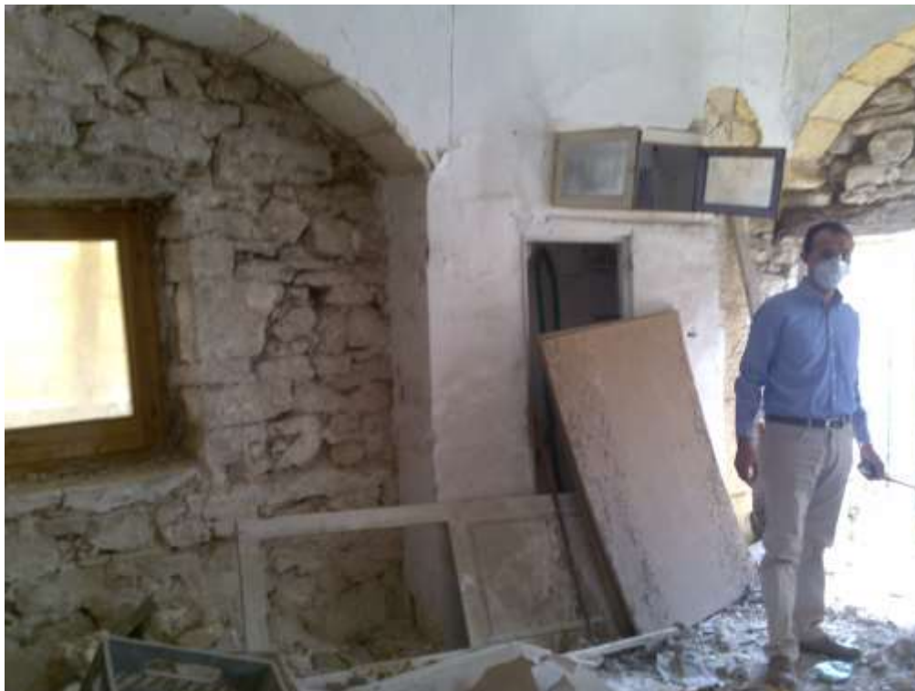
Particella 47 – Sub 2 - Foto n°3 - Vista interno locale
