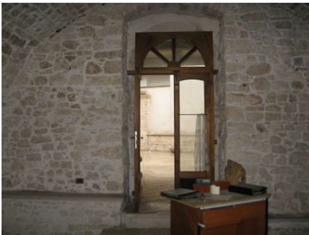
Particella 46 – Sub 1 - Foto n°20 - Vista interno locale
