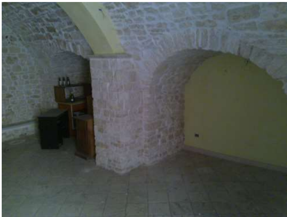
Particella 44 – Sub 5 - Foto n°9 - Vista interno locale
