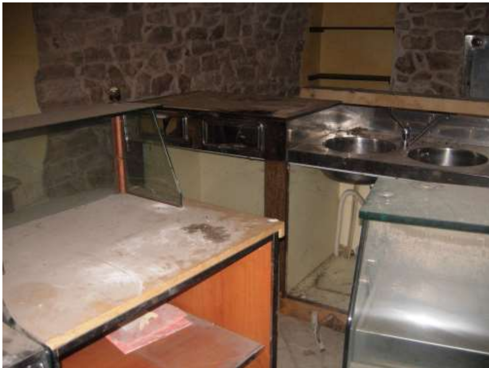
Particella 46 – Sub 1 - Foto n°23 - Vista interno locale
