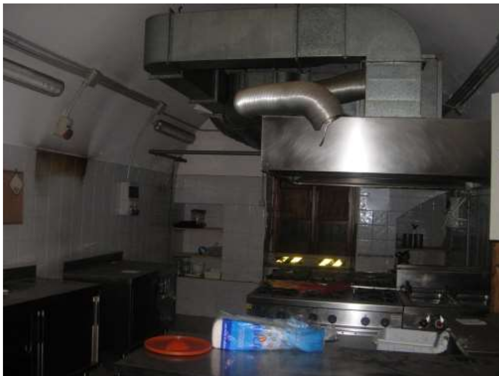
Particella 44 – Sub 5 - Foto n°5 - Vista interno locale
