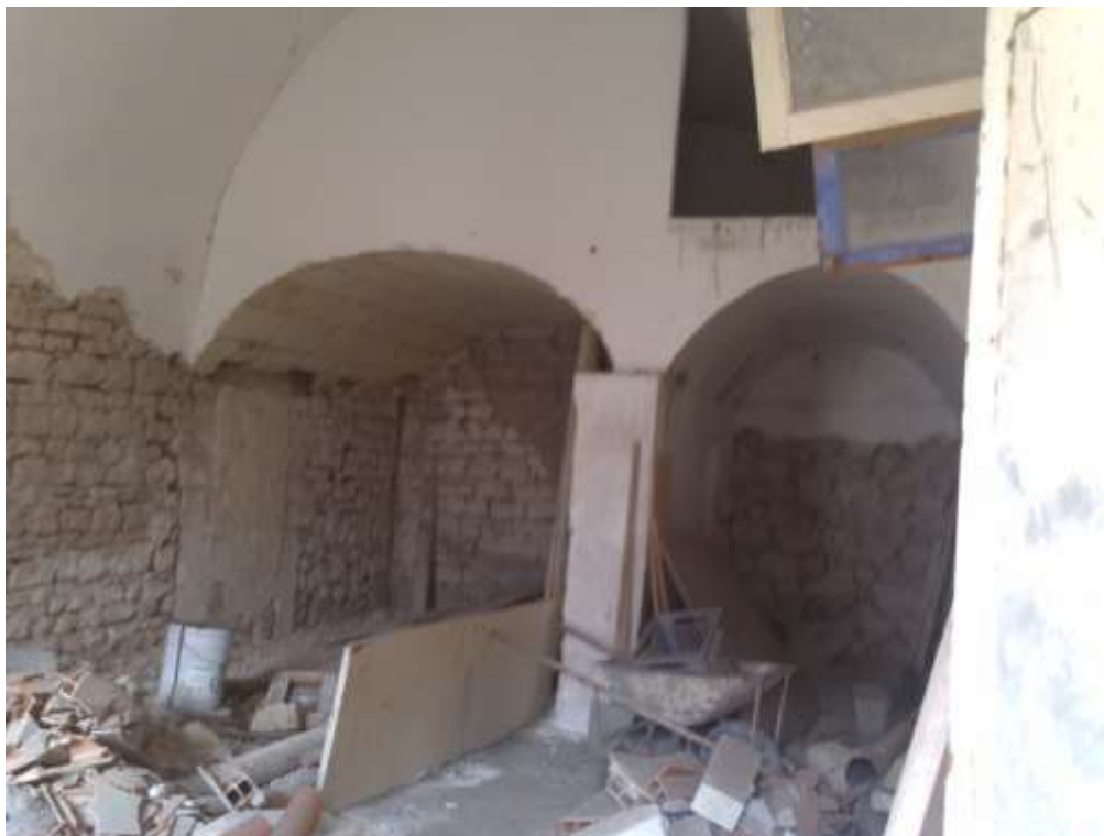
Particella 47 – Sub 2 - Foto n°6 - Vista interno locale
