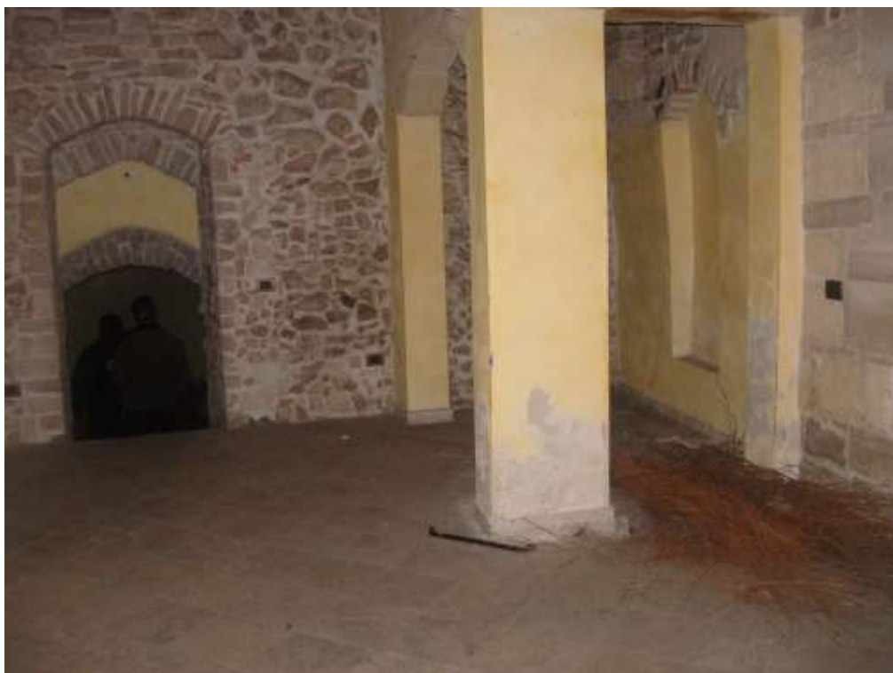
Particella 46 – Sub 1 - Foto n°9 - Vista interno locale
