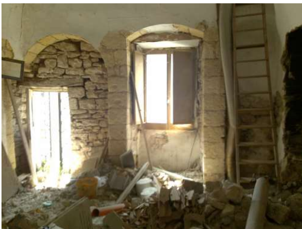
Particella 47 – Sub 2 - Foto n°7 - Vista interno locale
