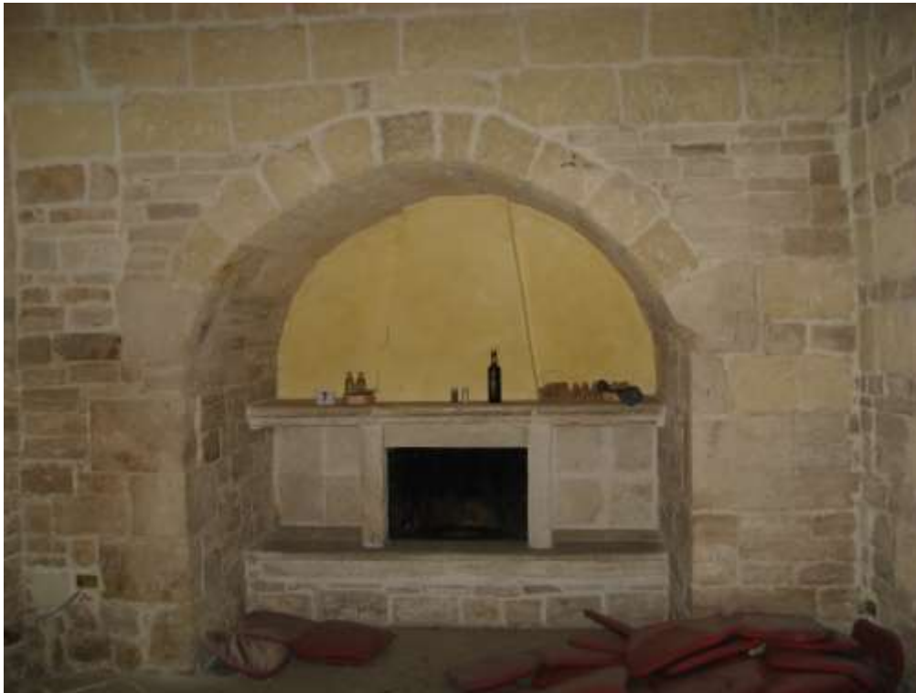
Particella 46 – Sub 1 - Foto n°18 - Vista interno locale
