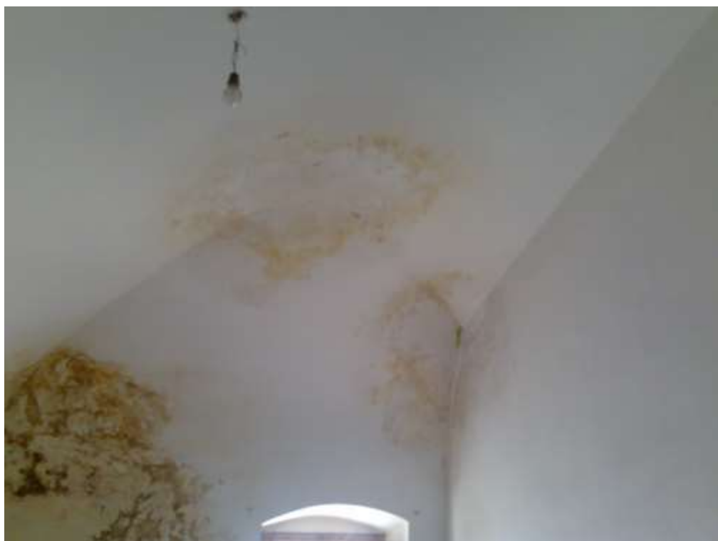
Foto n°8 Vista Interno Appartamento
