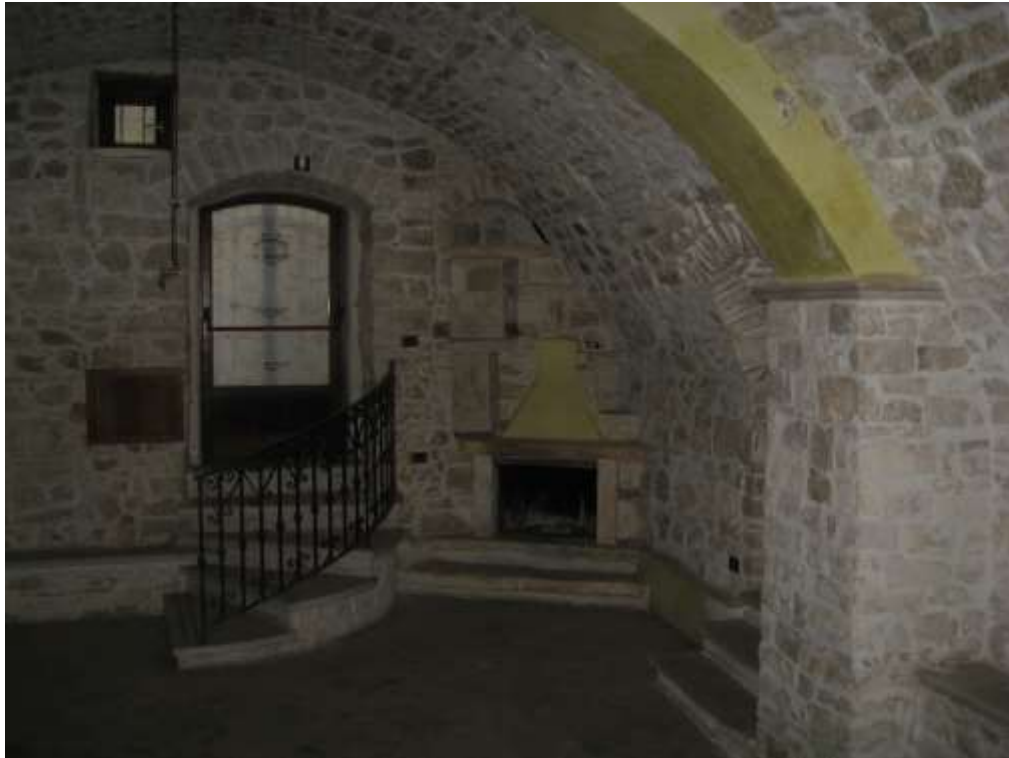
Particella 46 – Sub 1 - Foto n°10 - Vista interno locale
