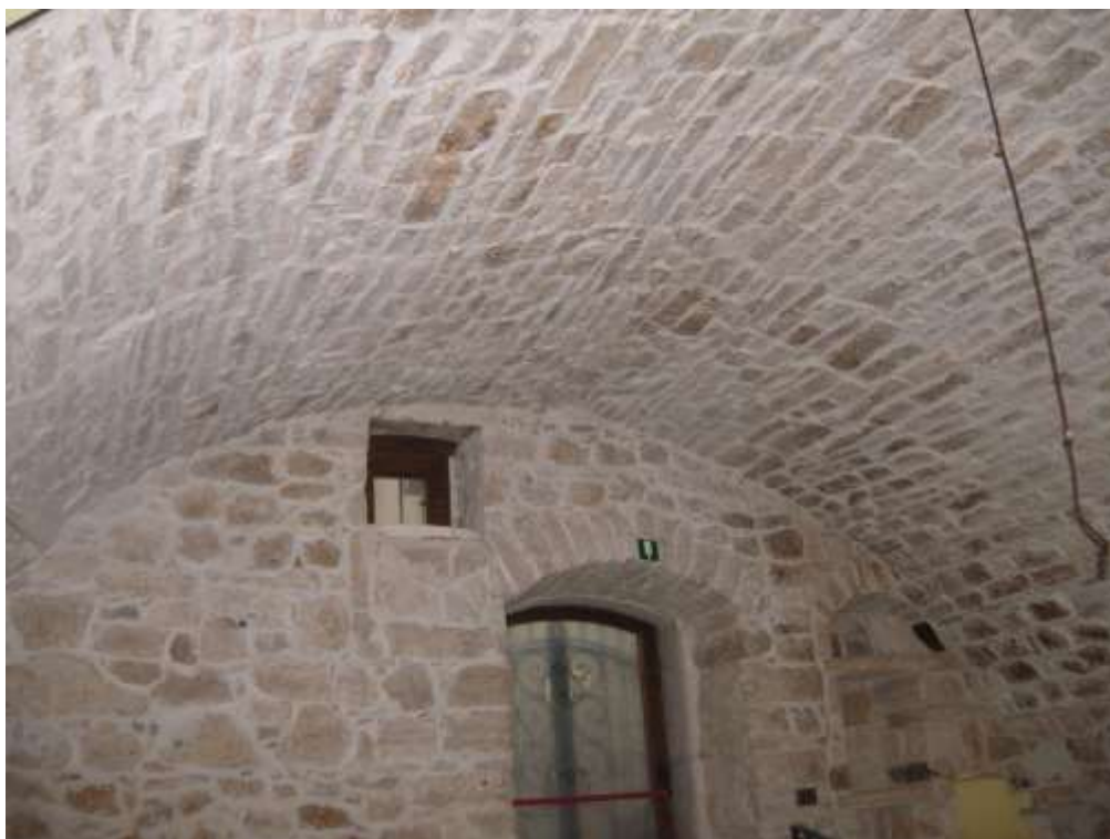
Particella 46 – Sub 1 - Foto n°15 - Vista interno locale
