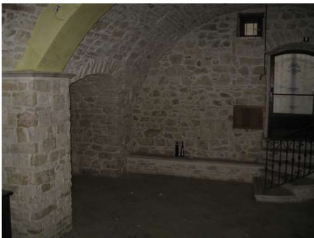
Particella 46 – Sub 1 - Foto n°21 - Vista interno locale
