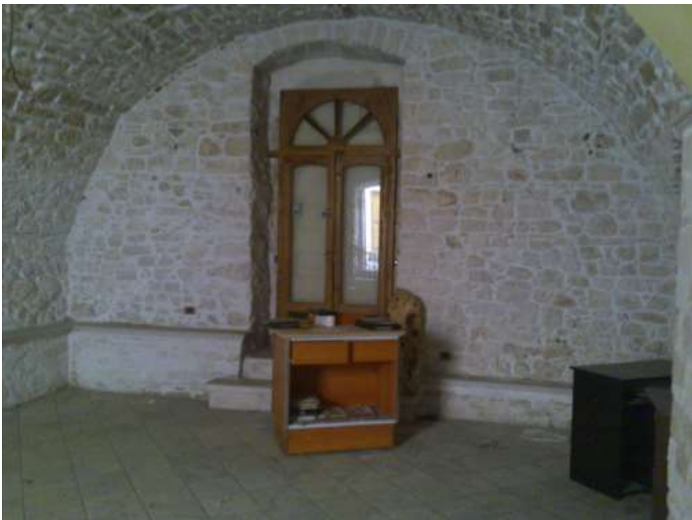
Particella 44 – Sub 5 - Foto n°8 - Vista interno locale
