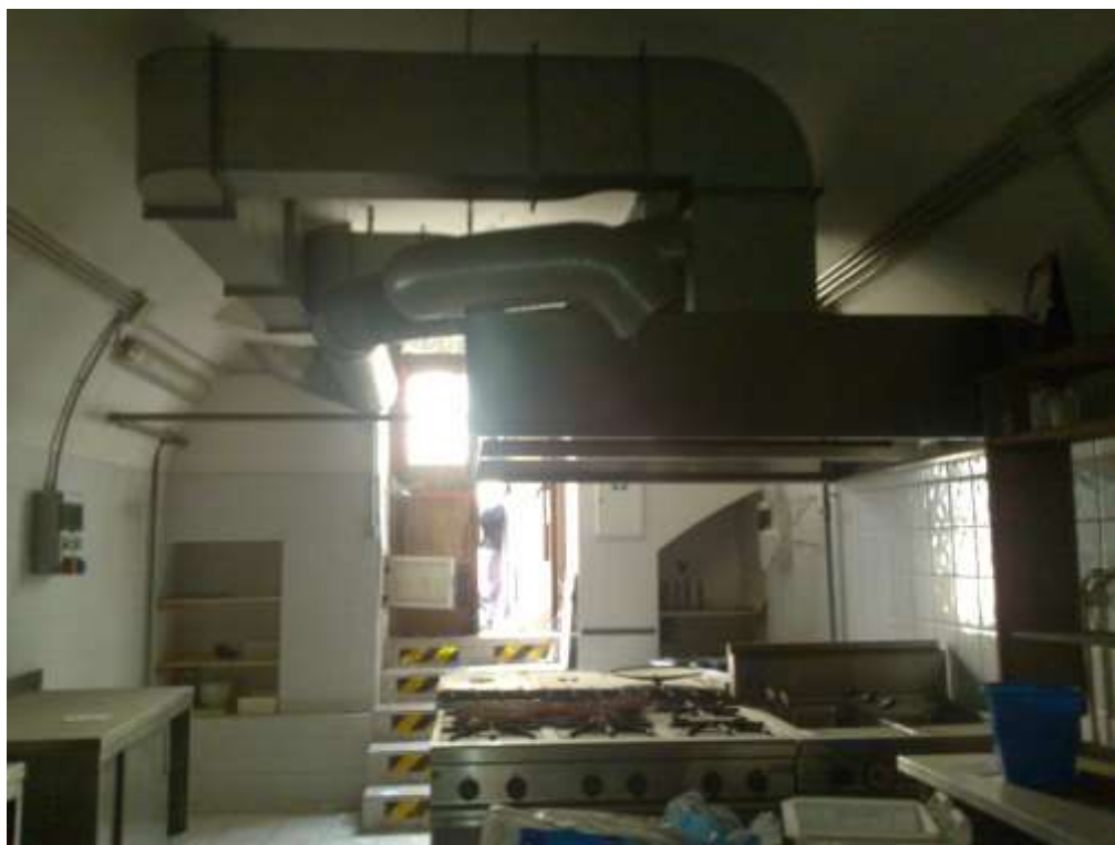
Particella 44 – Sub 5 - Foto n°3 - Vista interno locale
