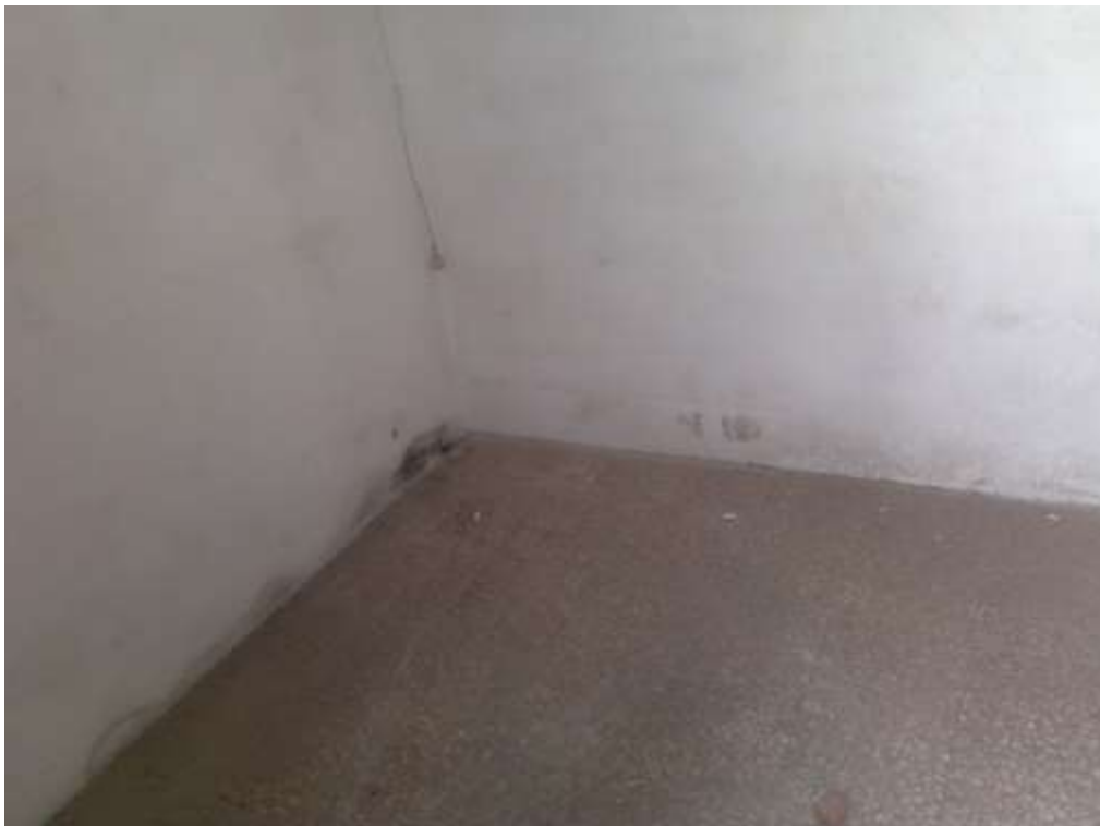
Foto n°13 Vista Interno Appartamento
