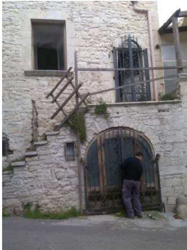
Particella 47 – Sub 1 - Foto n°4 - Vista prospetto anteriore
