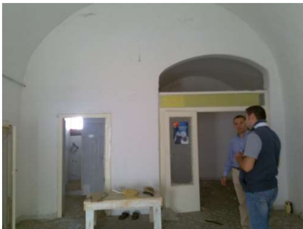
Foto n°3 Vista interno appartamento
