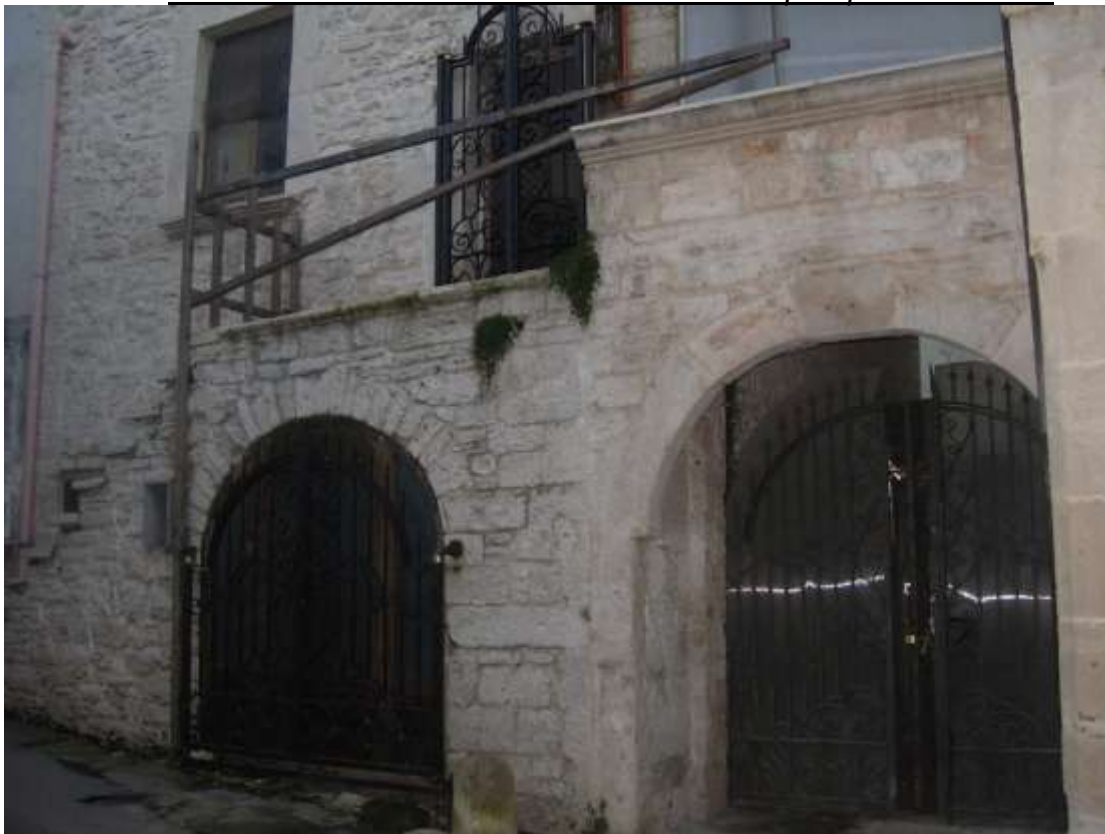
Particella 47 – Sub 1 - Foto n°3 - Vista prospetto anteriore
