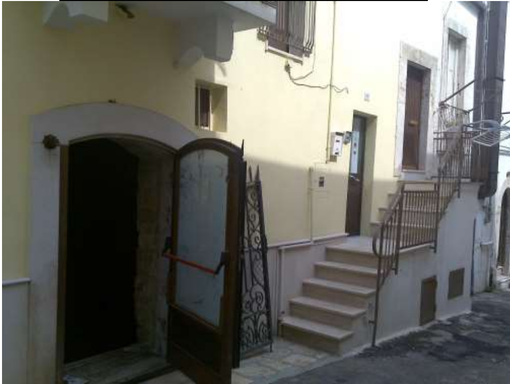
Particella 44 – Sub 5 - Foto n°1 - Vista prospetto anteriore
