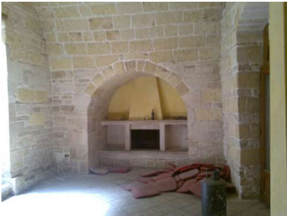
Particella 46 – Sub 1 - Foto n°14 - Vista interno locale
