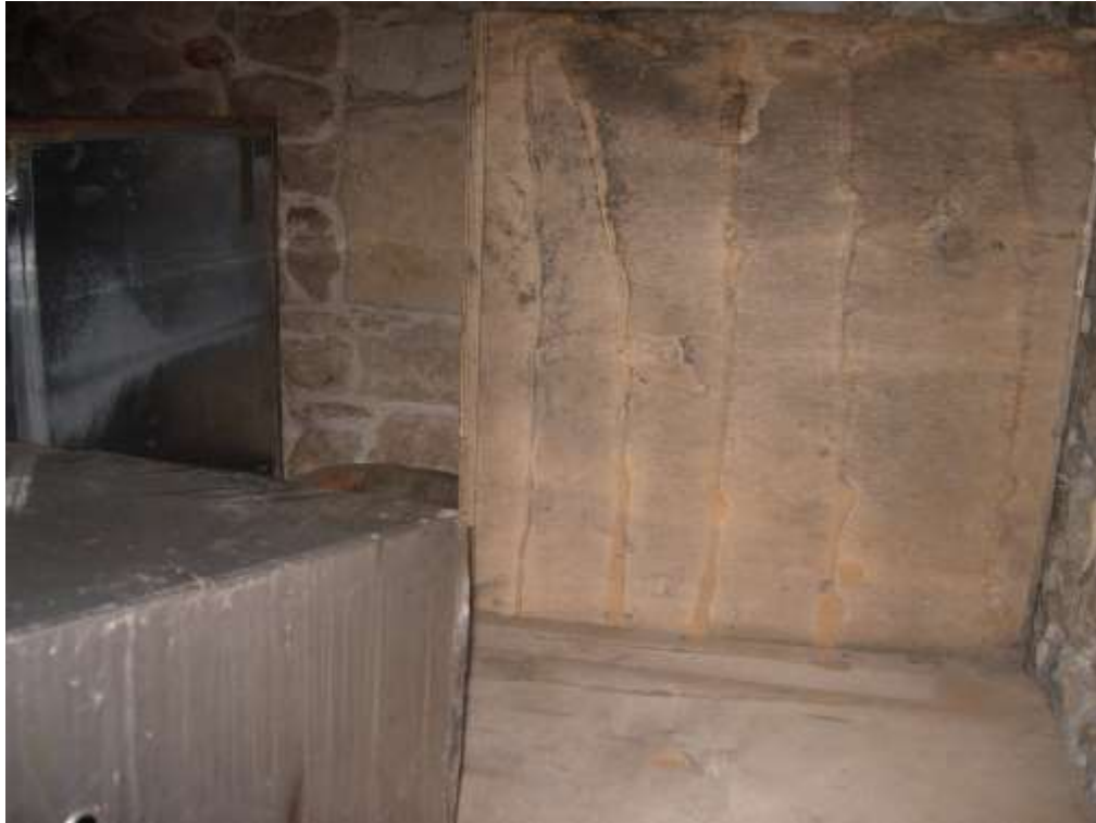
Particella 46 – Sub 1 - Foto n°22 - Vista interno locale
