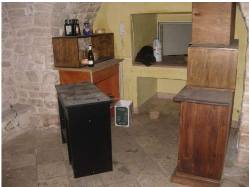
Particella 46 – Sub 1 - Foto n°27 - Vista interno locale
