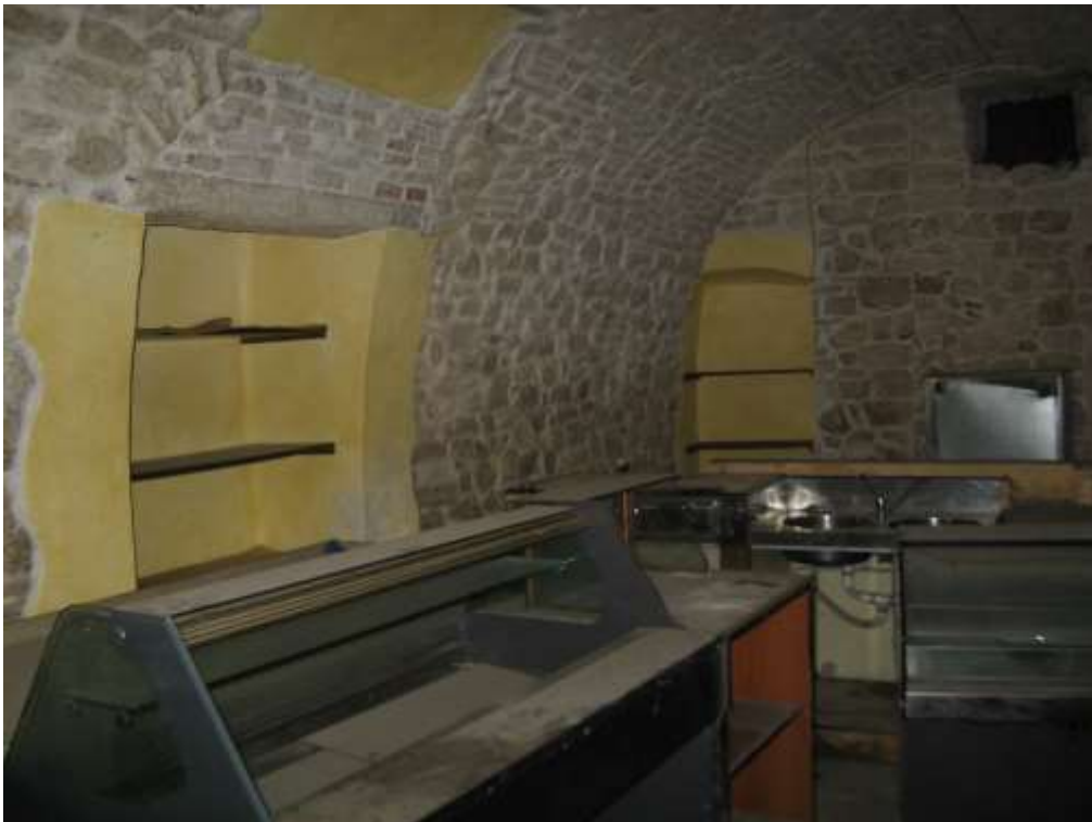
Particella 44 – Sub 5 - Foto n°7 - Vista interno locale
