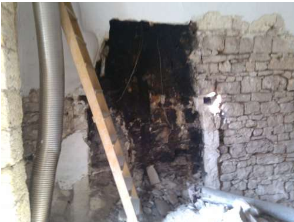
Particella 47 – Sub 2 - Foto n°5 - Vista interno locale
