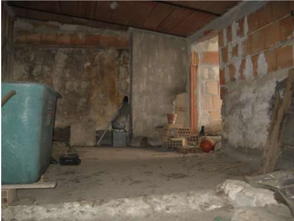
Foto n°13 Vista ammezzato per accesso terrazzo
