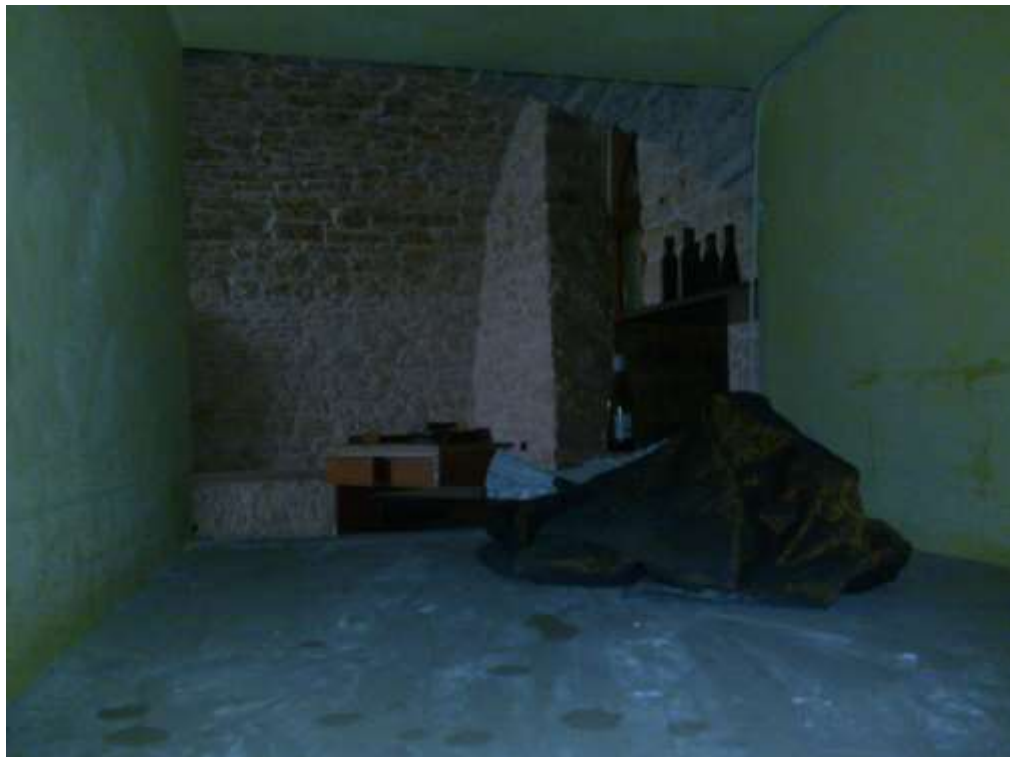
Particella 44 – Sub 5 - Foto n°6 - Vista interno locale
