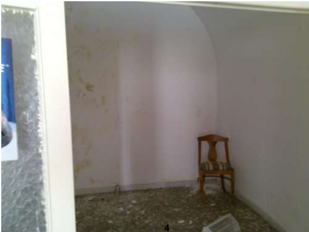
Foto n°4 Vista interno appartamento
