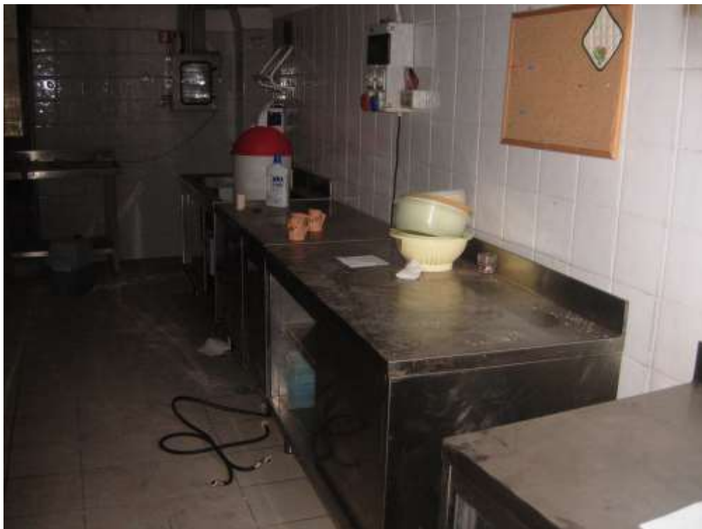
Particella 44 – Sub 5 - Foto n°7 - Vista interno locale
