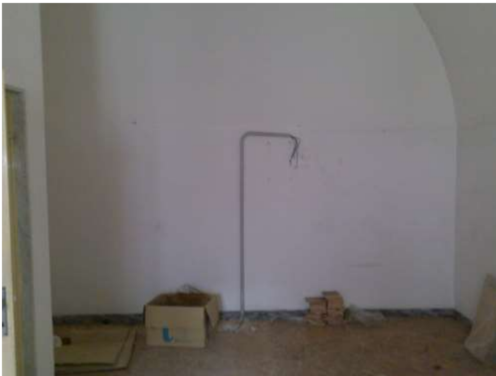
Foto n°11 Vista Interno Appartamento
