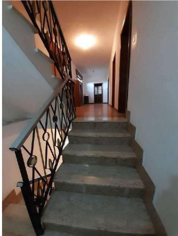
SCALA PER ACCESSO AL PIANO PRIMO
