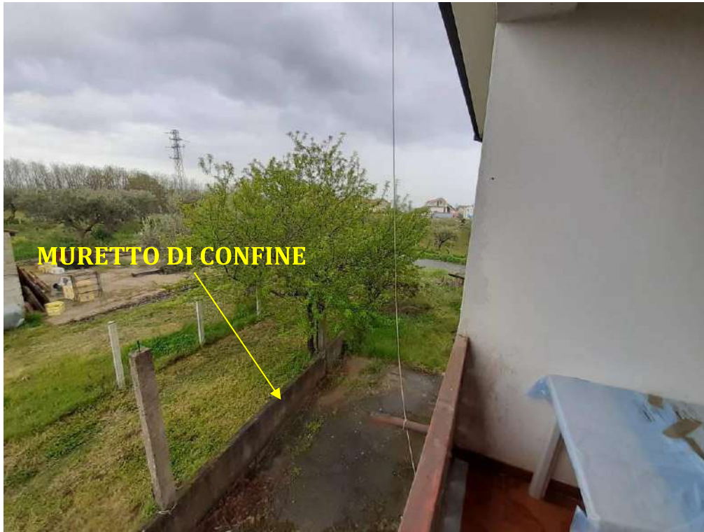
MURO SUL RETRO DI CONFINE CON IL SUB 7
