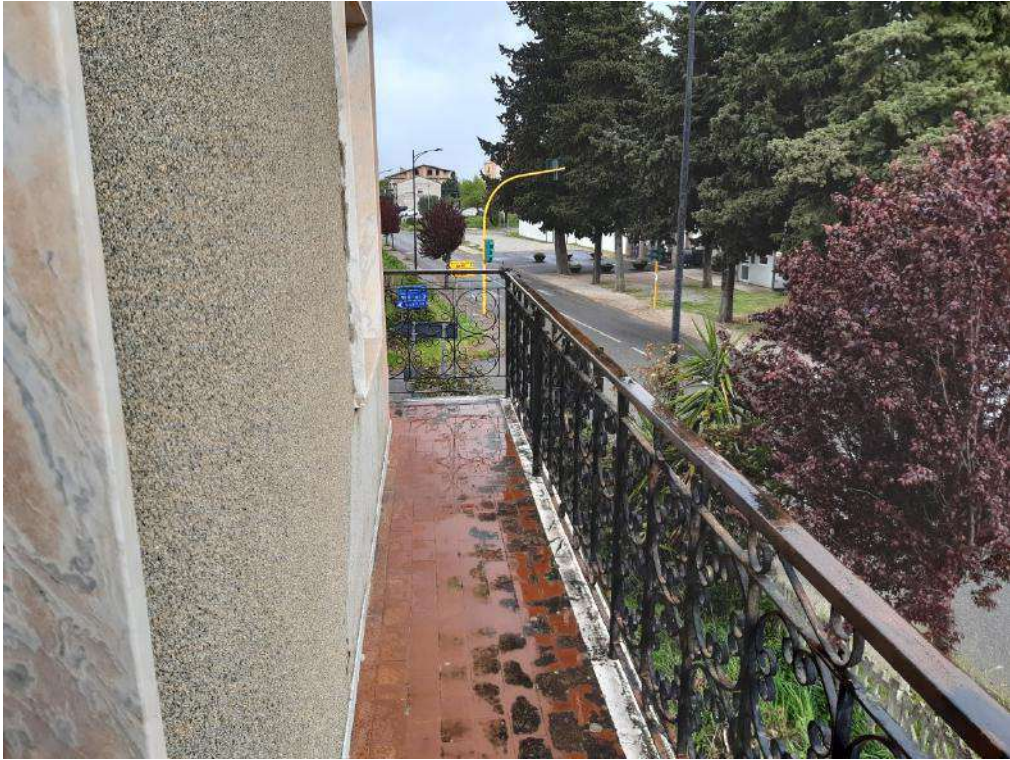
BALCONE LATO SUD
