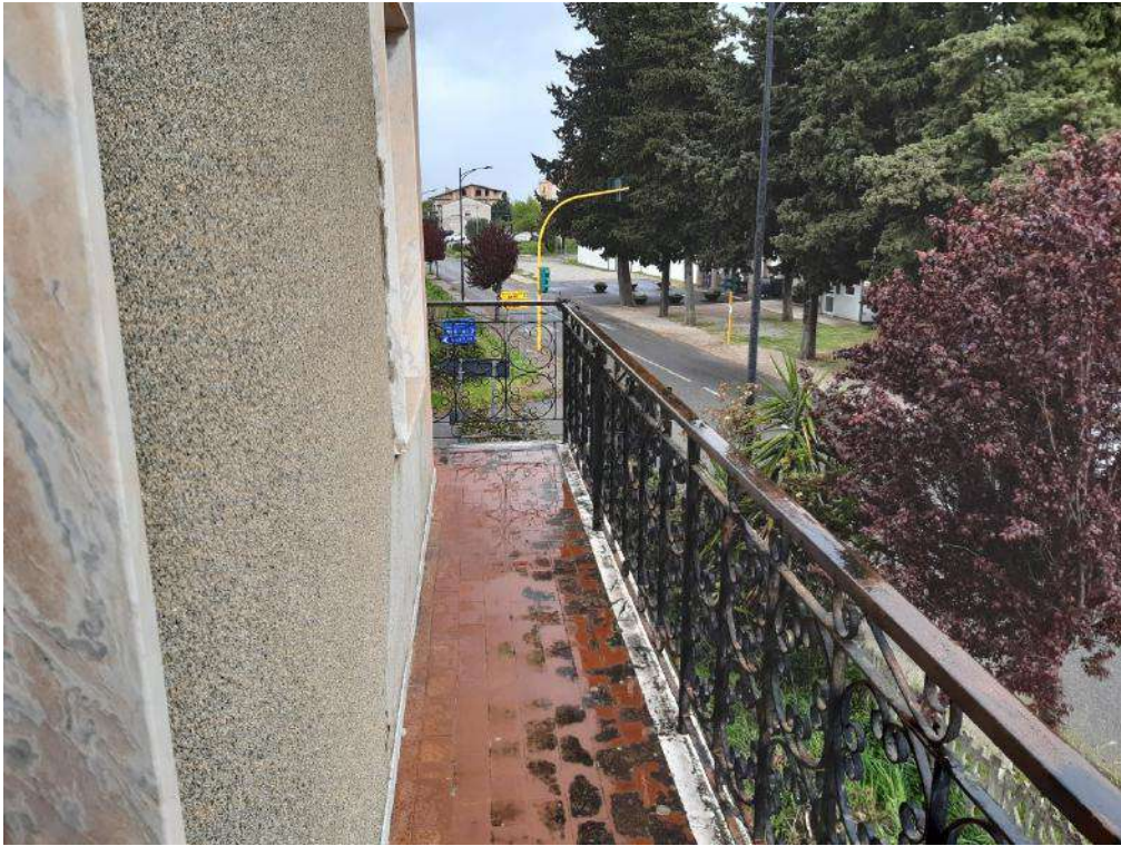
BALCONE LATO SUD
