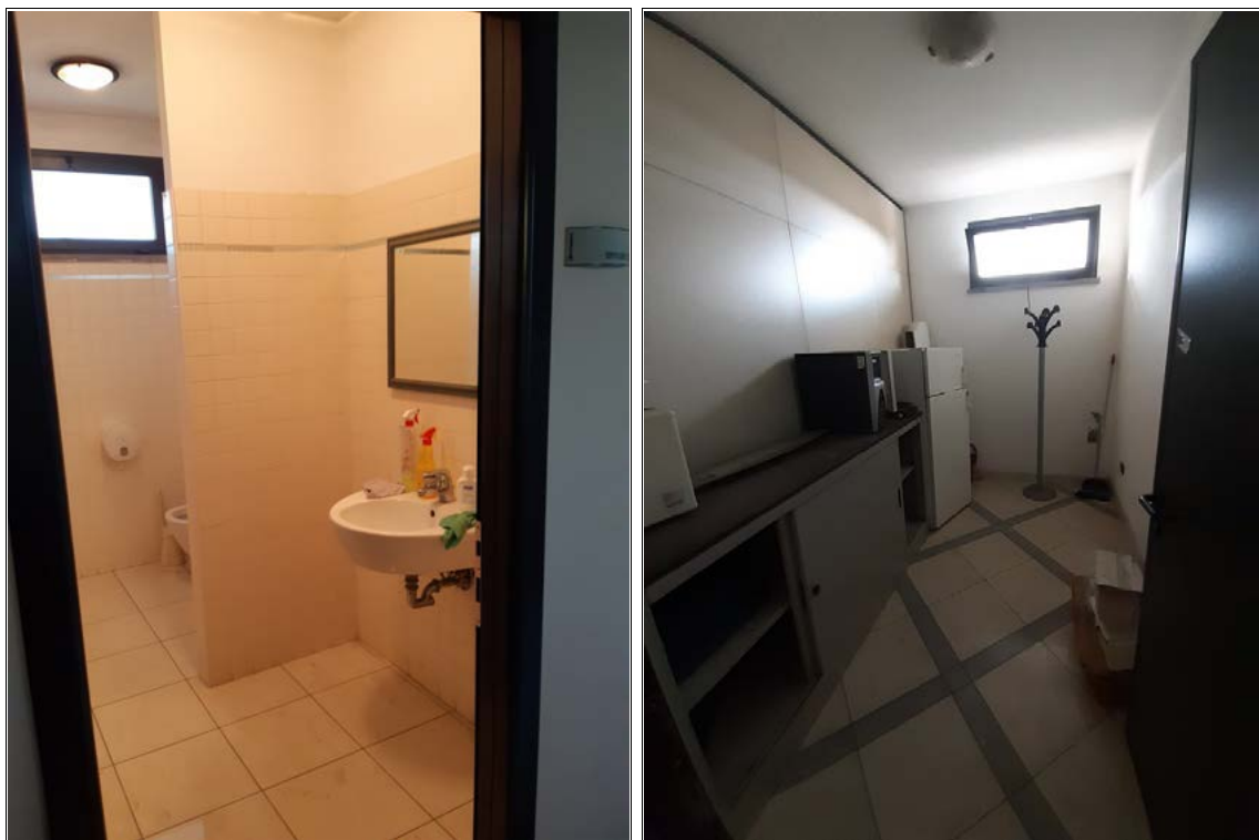
FOTO 24-25 – Piano primo: servizio igienico e ripostiglio.
