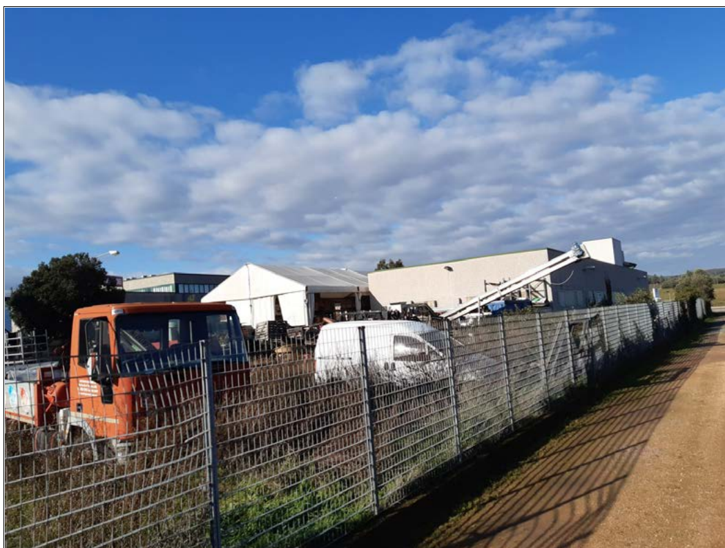
FOTO 60 – Vista dell'immobile dall'esterno, sul lato nord-est, a confine con una strada privata che si innesta sulla S.P. Aurelia Vecchia.
