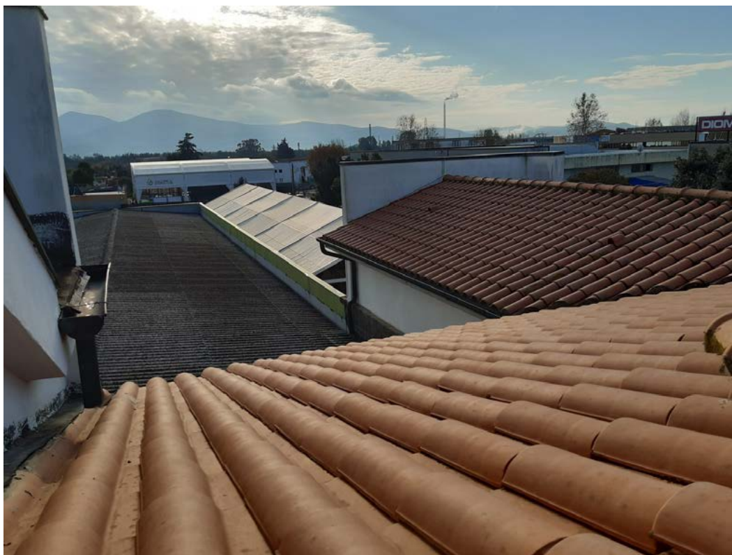
FOTO 27 – Terrazza a tasca al piano 2°: vista sulle coperture della palazzina uffici e del capannone.
