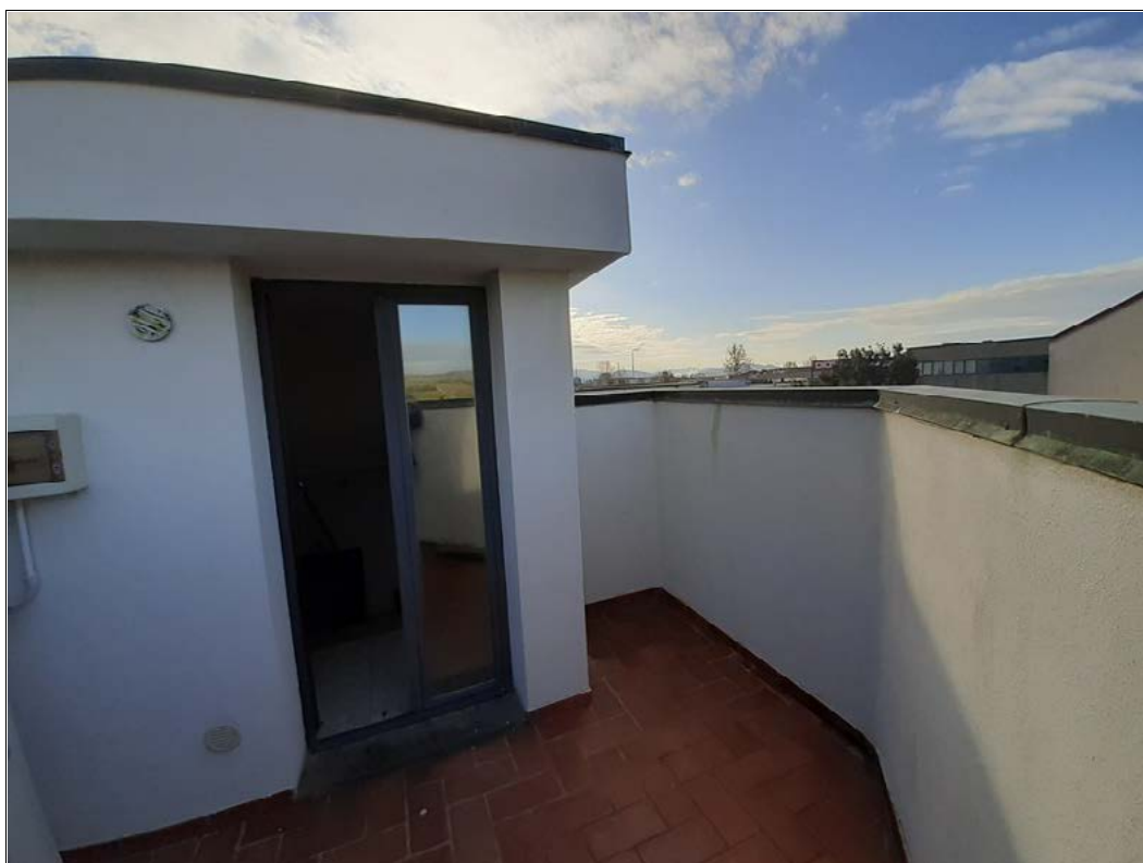
FOTO 26 – Piano 2°: la terrazza a tasca che ospita i motori dei climatizzatori degli uffici.
