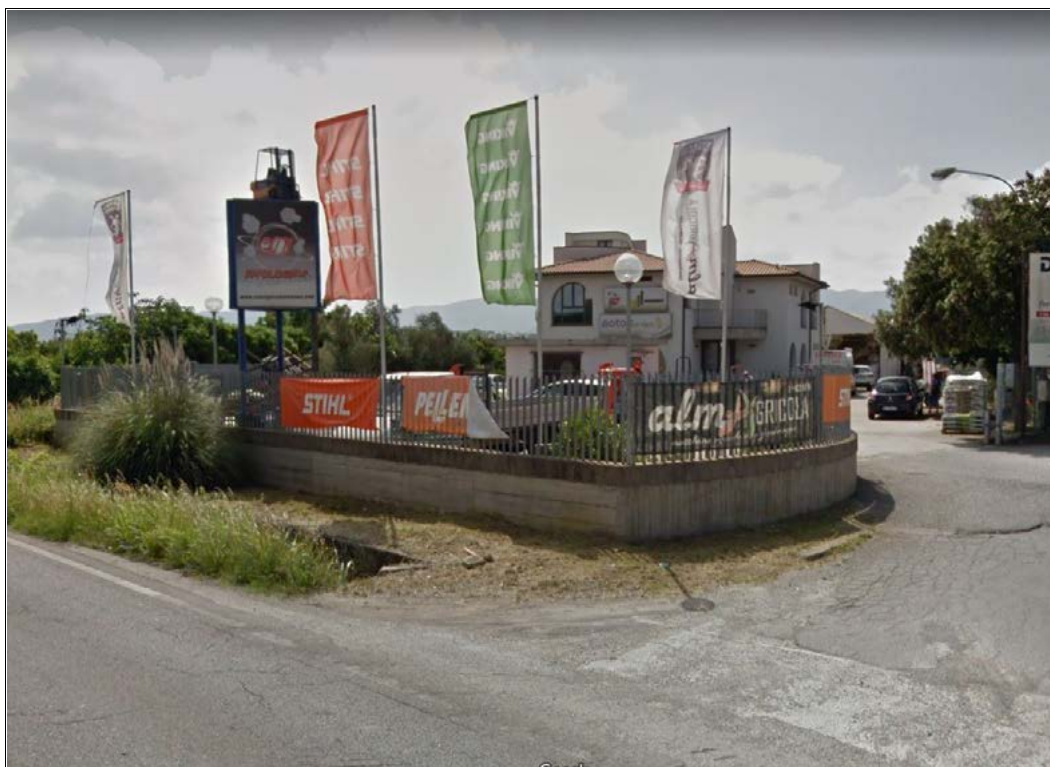
FOTO 1 – Follonica (GR), zona industriale-artigianale. Vista dell'immobile oggetto di stima dalla strada provinciale Aurelia Vecchia.
