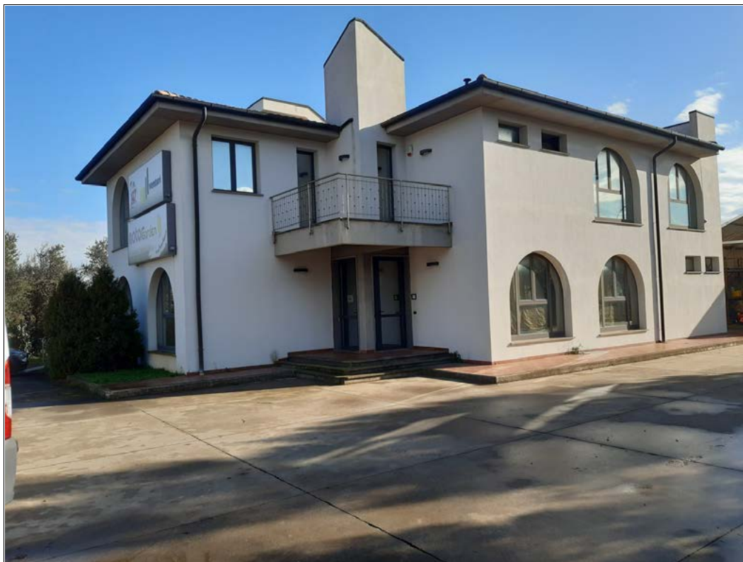
FOTO 3 – La palazzina ad uso direzionale-uffici. Al centro, sotto al terrazzo, si aprono i due portoncini di accesso alla porzione di fabbricato.
