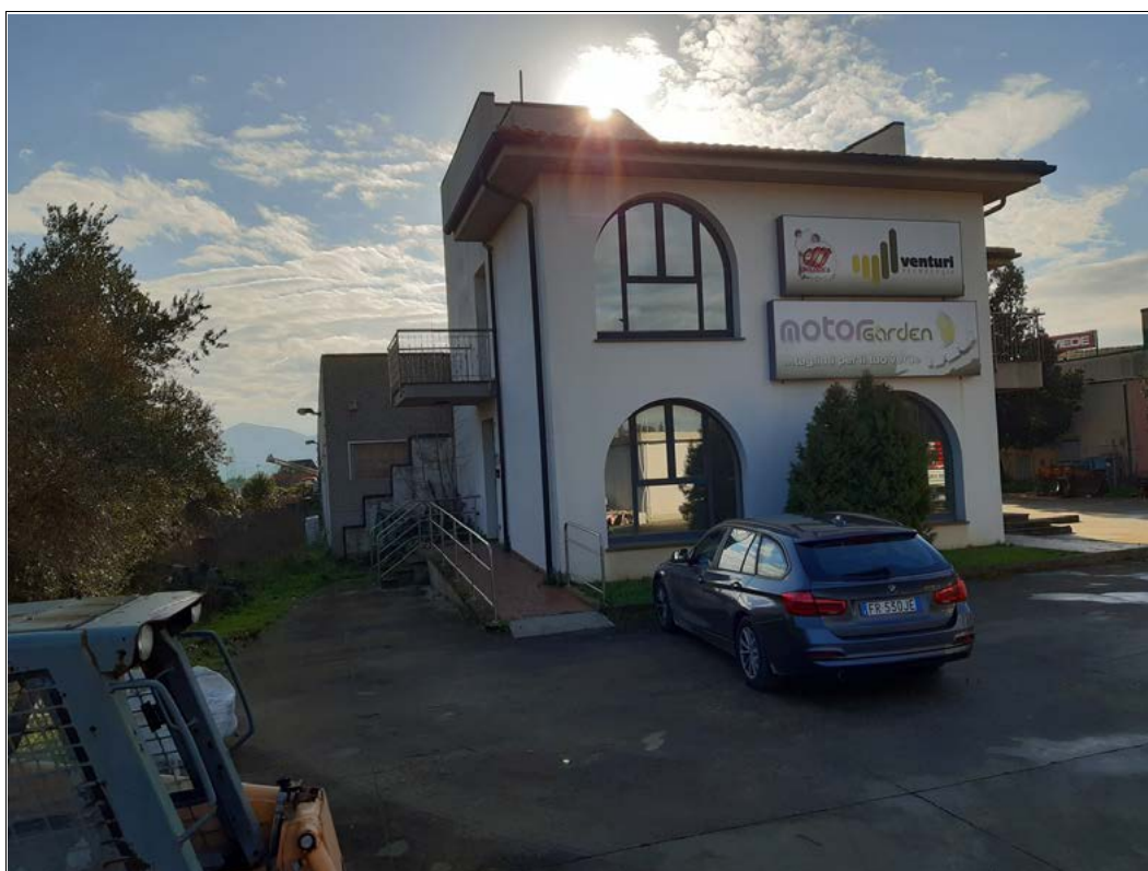
FOTO 4 – Lati nord ed est della palazzina. Al piano terra, sulla sinistra, l'accesso secondario alla palazzina dotato di scaletta e rampa per disabili. In secondo piano si scorge la sagoma dell'adiacente capannone artigianale prefabbricato.
