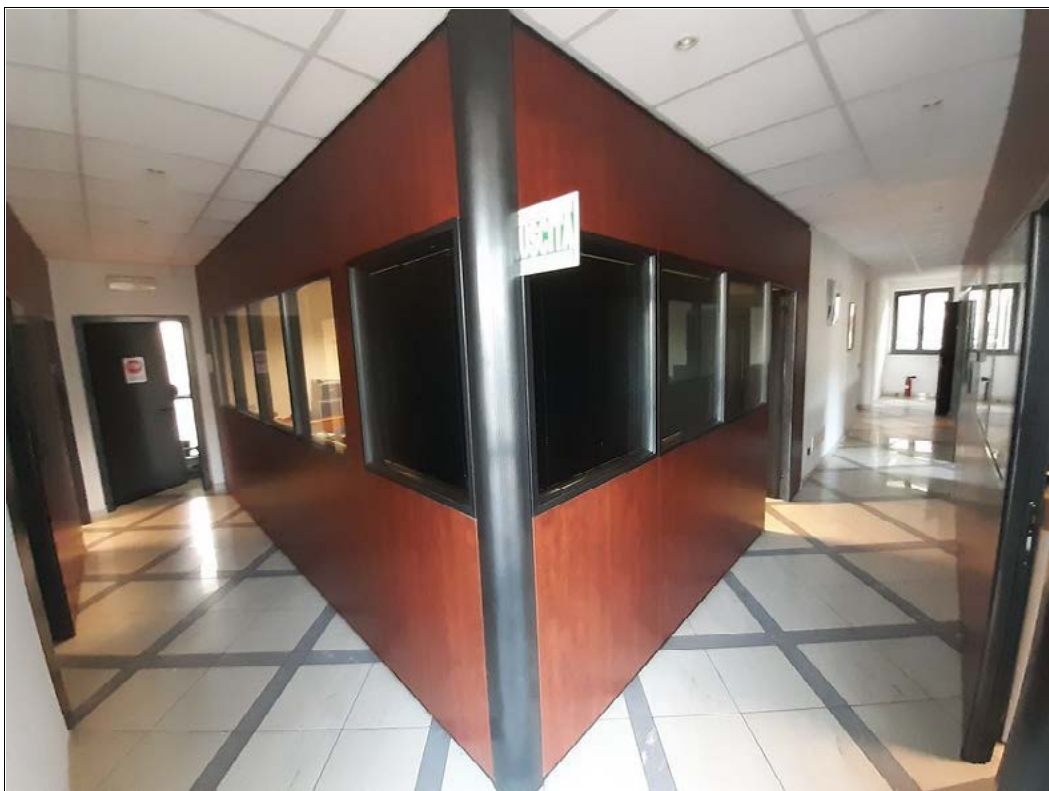
FOTO 6 – Corridoi distributivi al piano terra della palazzina uffici.
