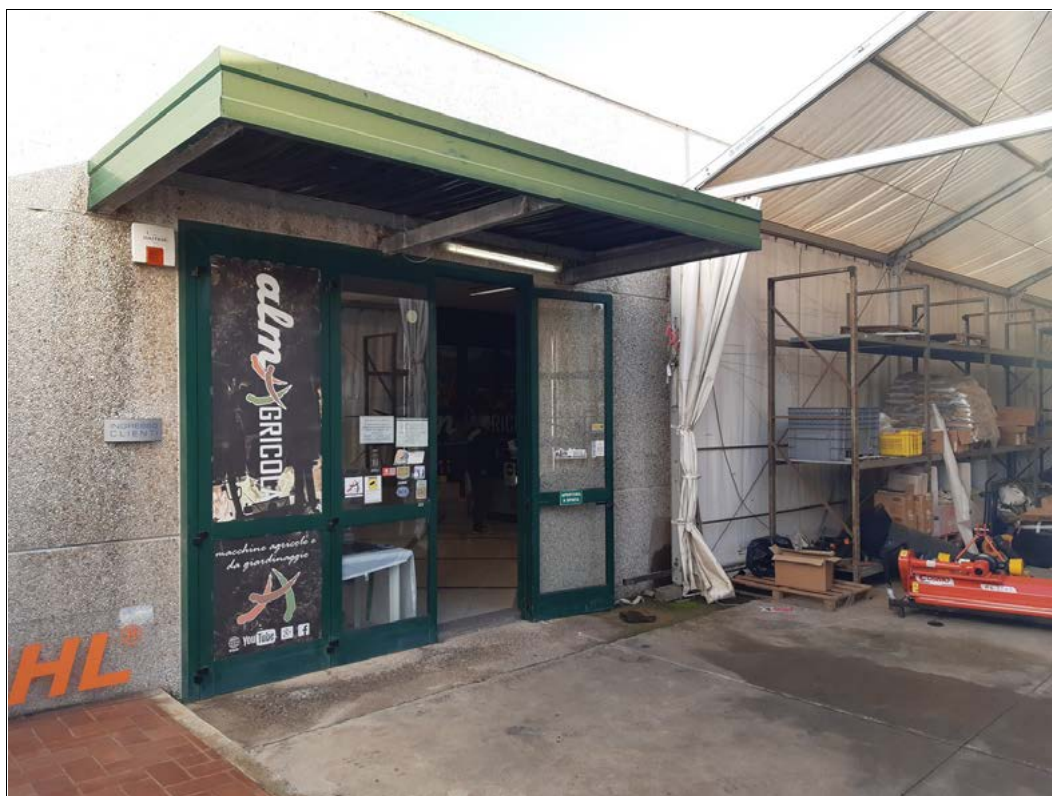
FOTO 38 – L'accesso al locale esposizione del capannone artigianale.
