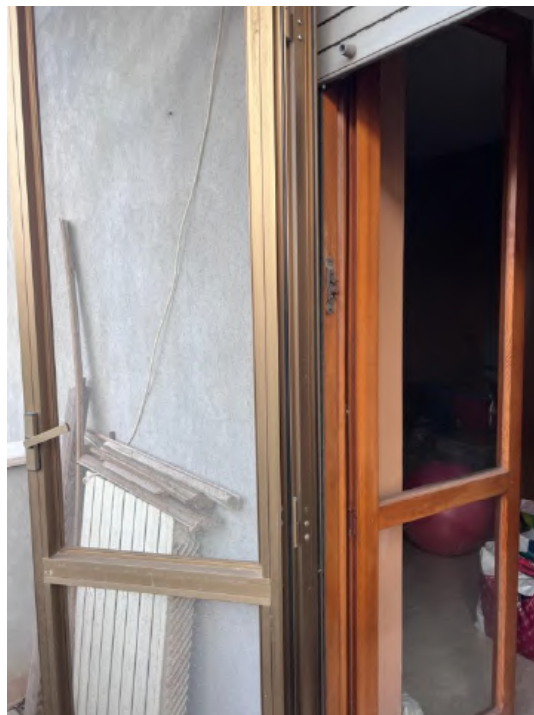
foto 14 – Particolare Infissi esterni della porta finestra ovest della sala
