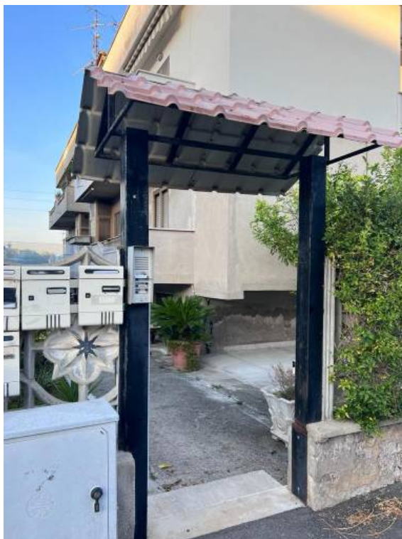
foto 1 – Vista ingresso palazzina Via Nicola Maria Nicolai n. 18 a Latina
