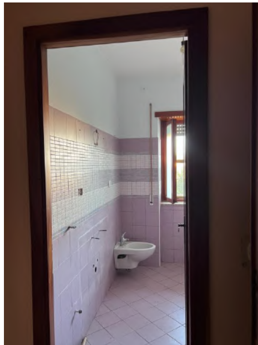
foto 16 – WC lato nord
