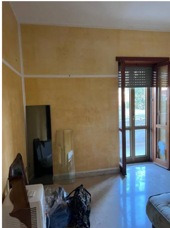
foto 19 – Particolare camera nord-est
