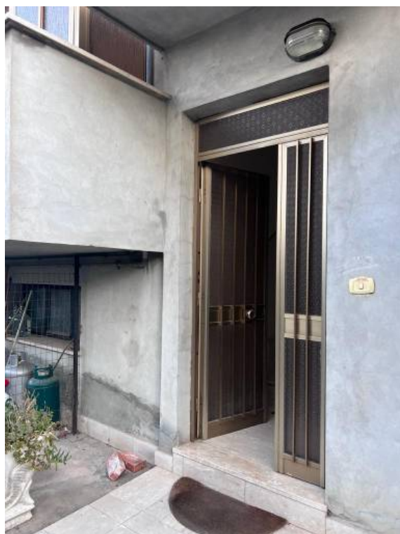
Foto 2 – Vista ingresso palazzina
