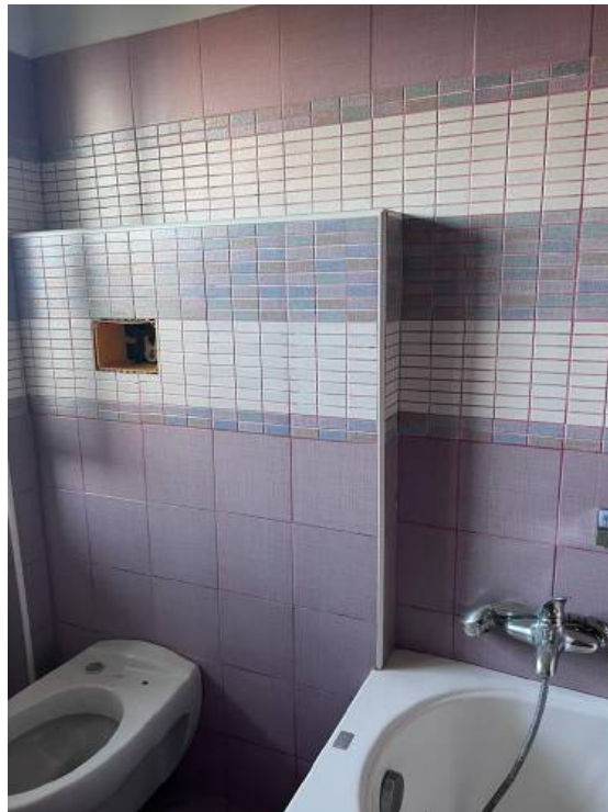
foto 17 – Particolare WC lato nord
