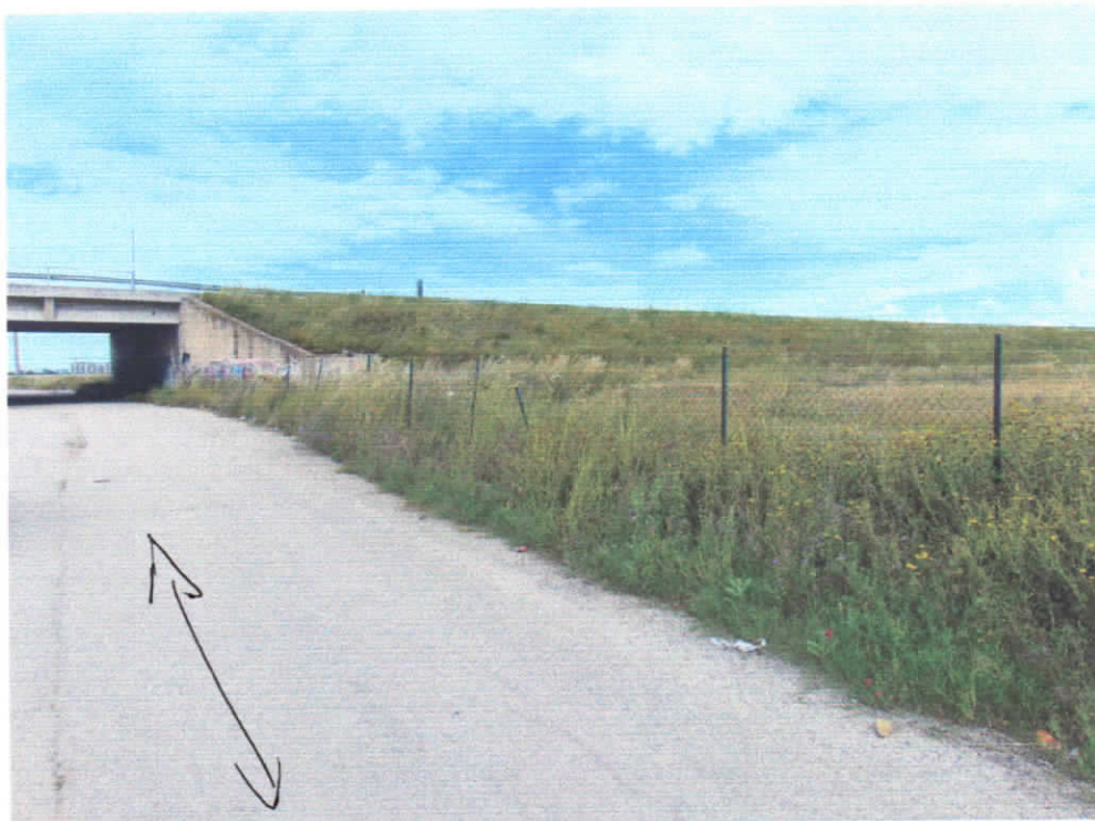
FOTO N.6: Stradina interpodereale (F.129, p.lla 289) ; recinzione metallica sulla dx.
