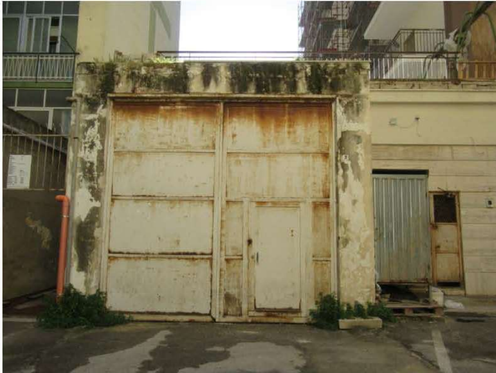
Foto 1_ Prospetto immobile su cortile condominiale
