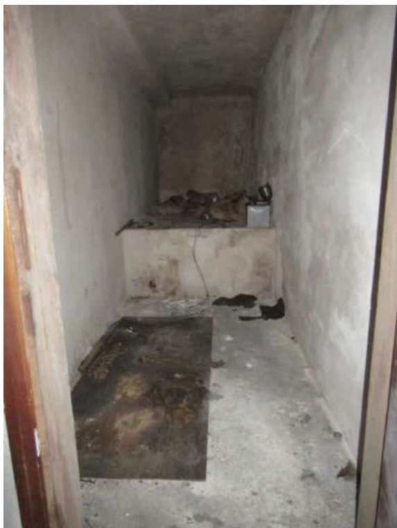
Foto 21_ Ripostiglio su rampa d'accesso
