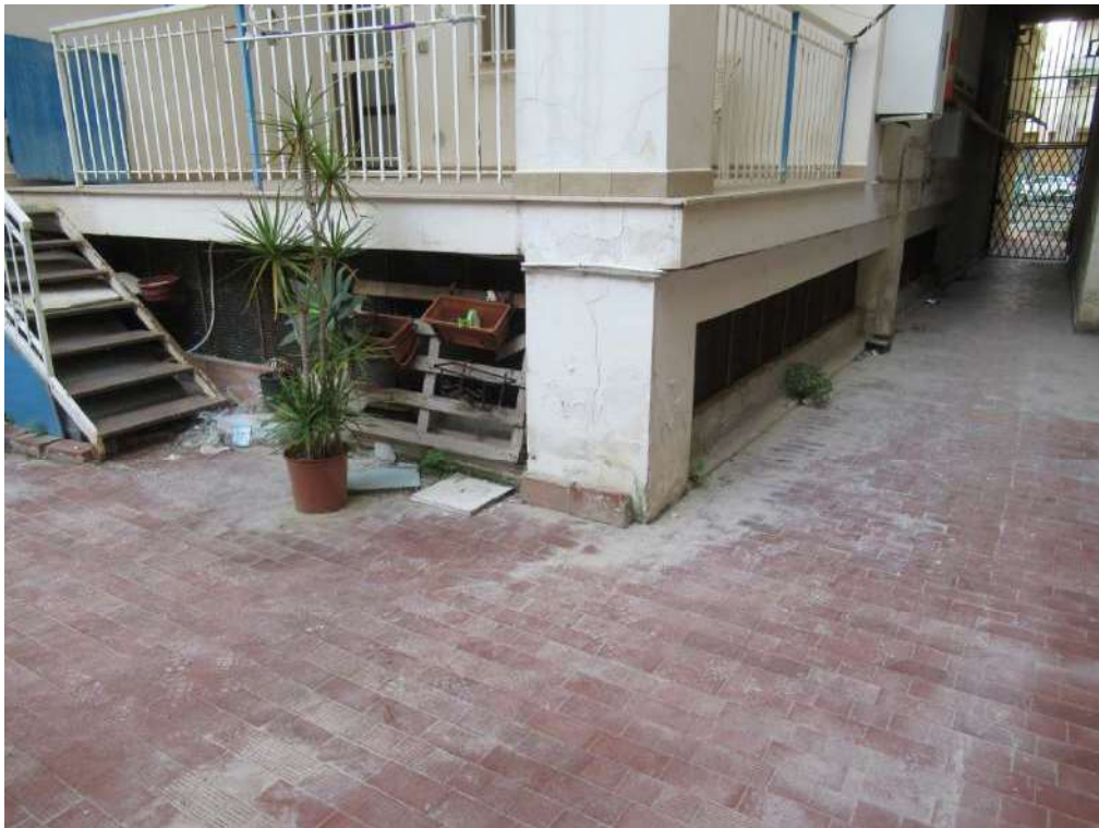
Foto 26_ Terrazzo condominiale piano terra lato ovest
