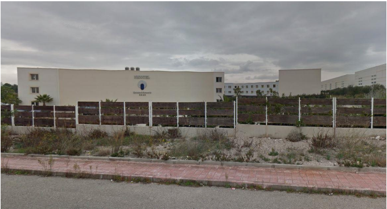
Figura 4 – Vista del complesso edilizio da Sud
