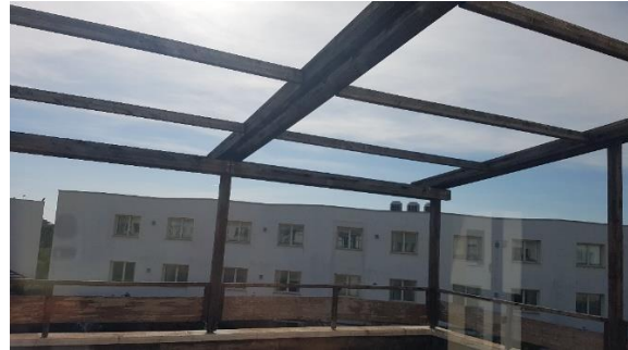
Figura 44 – Pergolato in legno con pilastri 20cmx20cm
