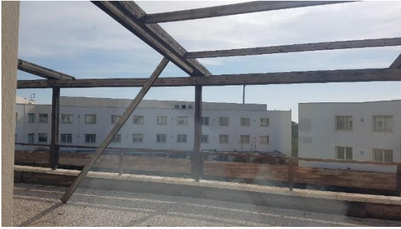
Figura 44 – Pergolato in legno con pilastri 20cmx20cm
