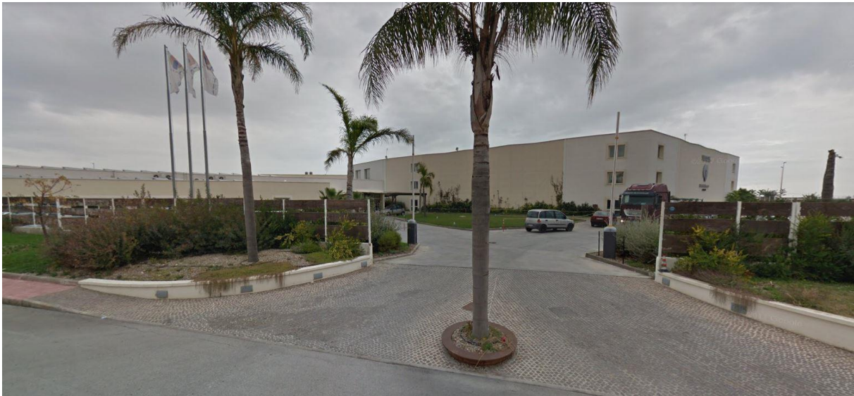
Figura 1 – Vista del complesso edilizio da Ovest
