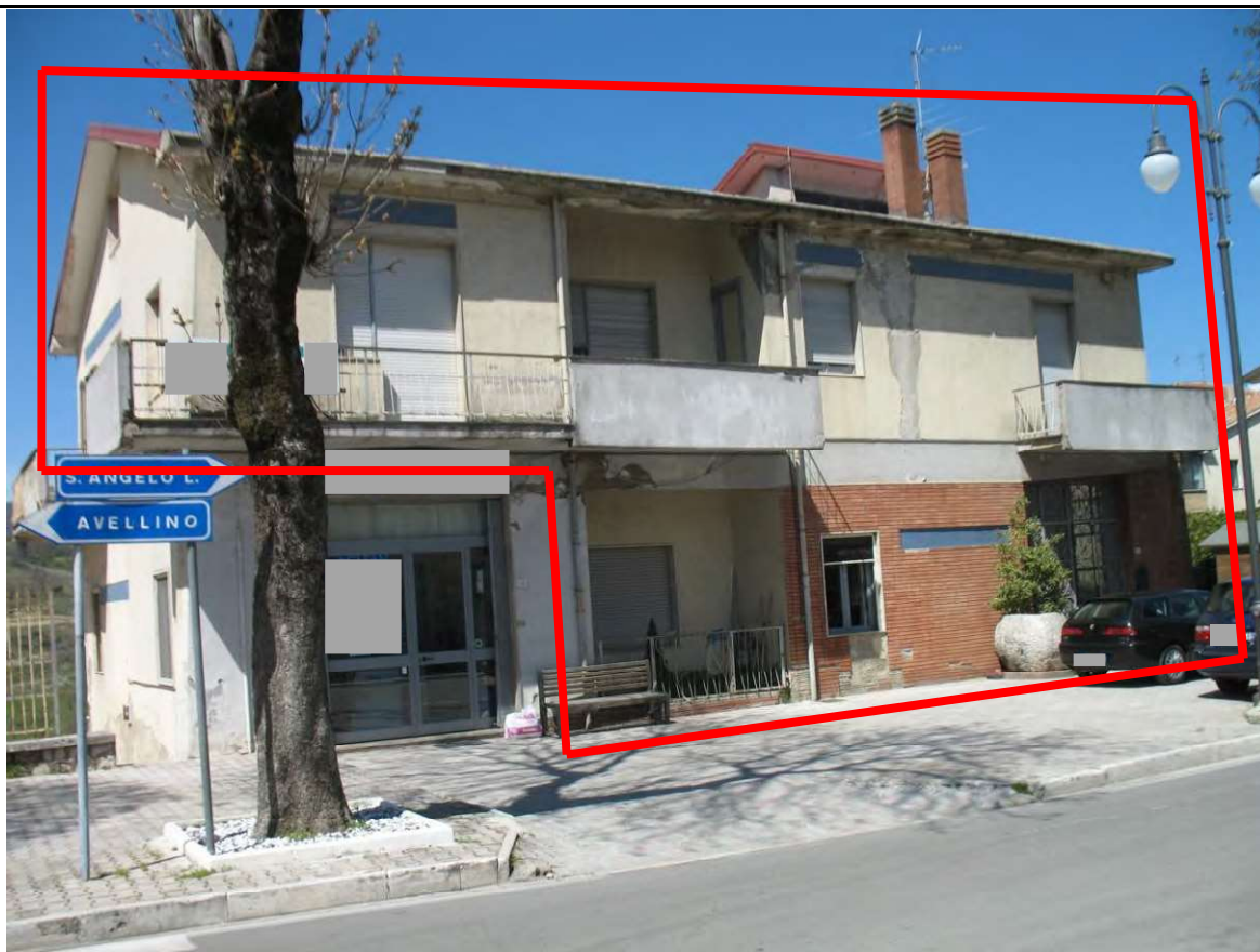
Foto 1: Prospetto principale prospiciente via San Francesco (lotto 1 evidenziato in rosso)
