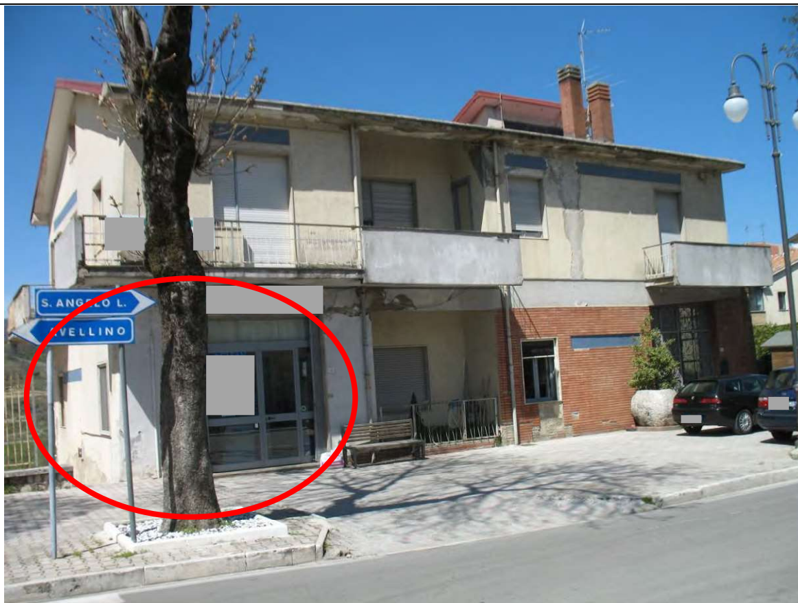
Foto 1: Prospetto principale prospiciente via San Francesco (lotto 2 evidenziato in rosso)
