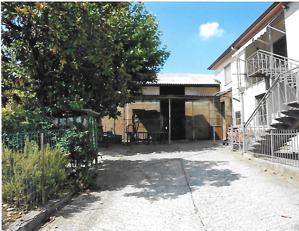
Foto 6 – Prospetto tettoia con avancorpo
