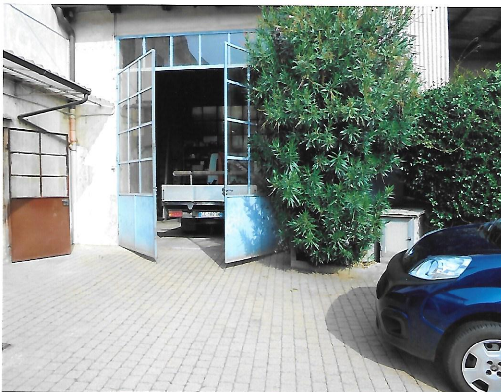
Foto 4 – Secondo prospetto da cortile su Via S.Lorenzo
