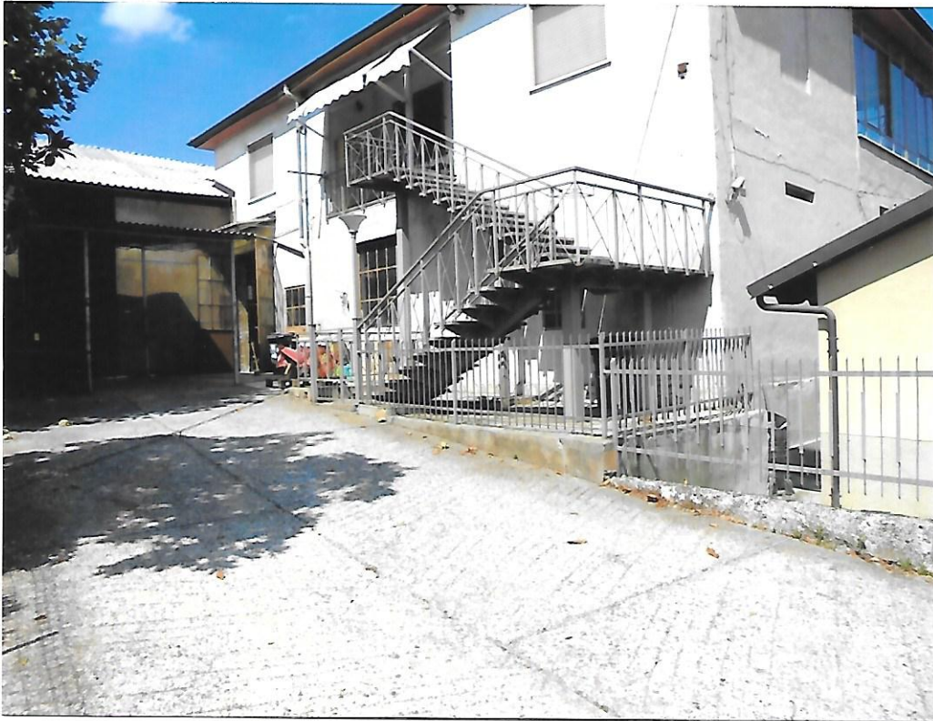
Foto 5- Fronte cortile su Prov.le-Solo piano terreno, con scala in ferro per accesso ad altrui proprietà
