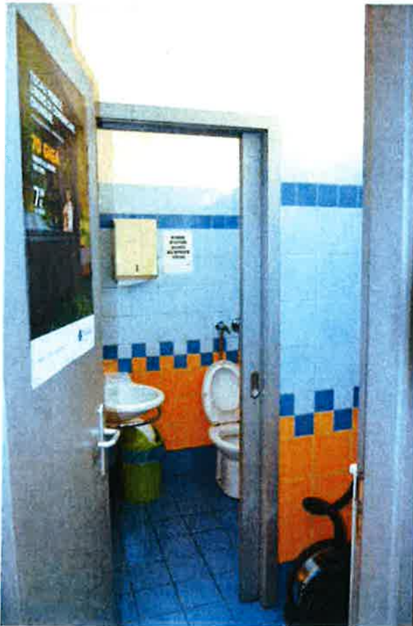
Fot. 10: piano terra, servizi igienici
