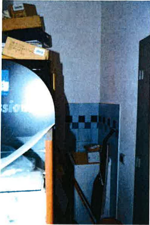
Fot. 17: piano primo, servizi igienici
