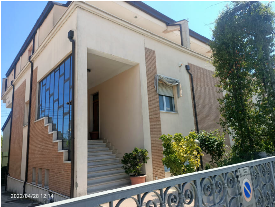
Comune di Porto Sant'Elpidio, Foglio 2 Particella 57 sub 1 ingresso
