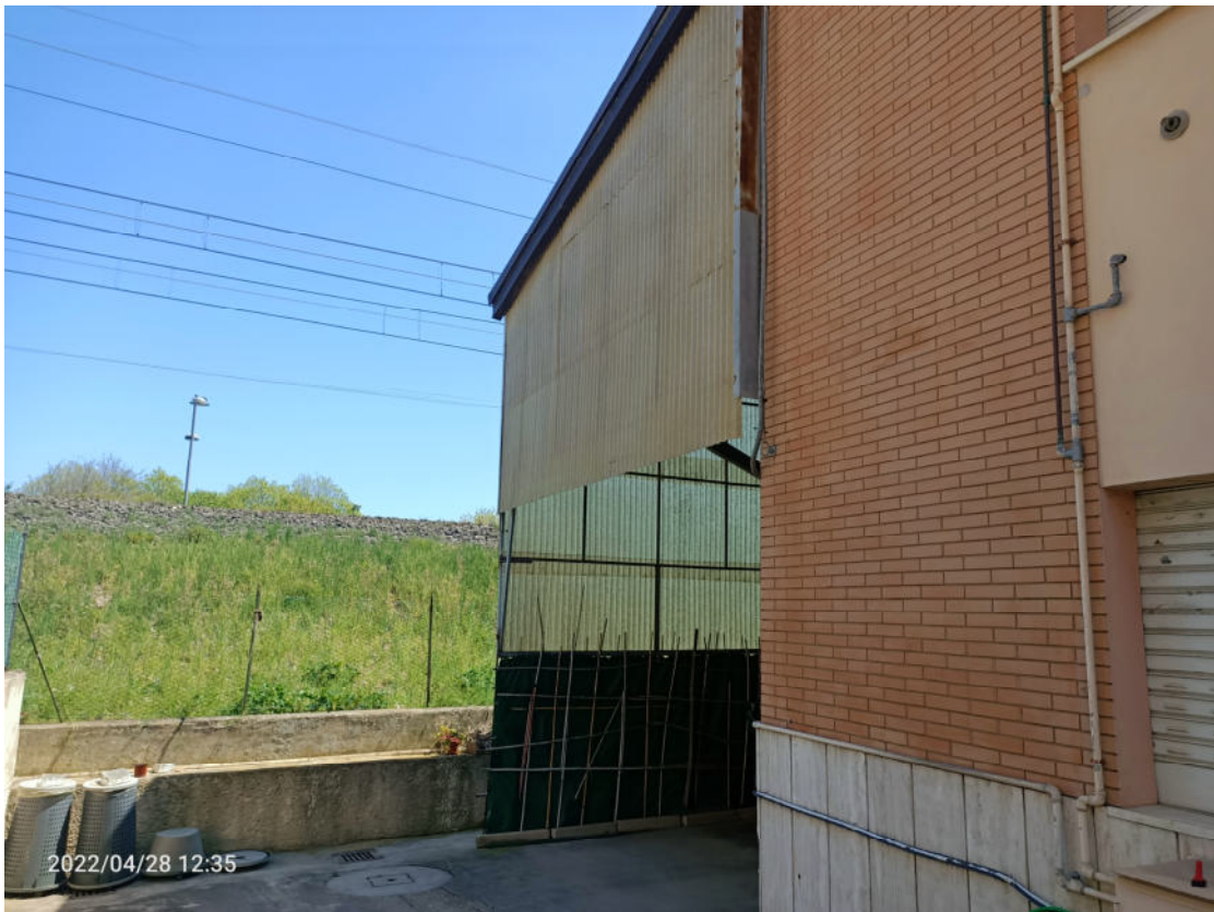
Comune di Porto Sant'Elpidio, Foglio 2 Particella 57 parziale copertura da tettoia esterna
