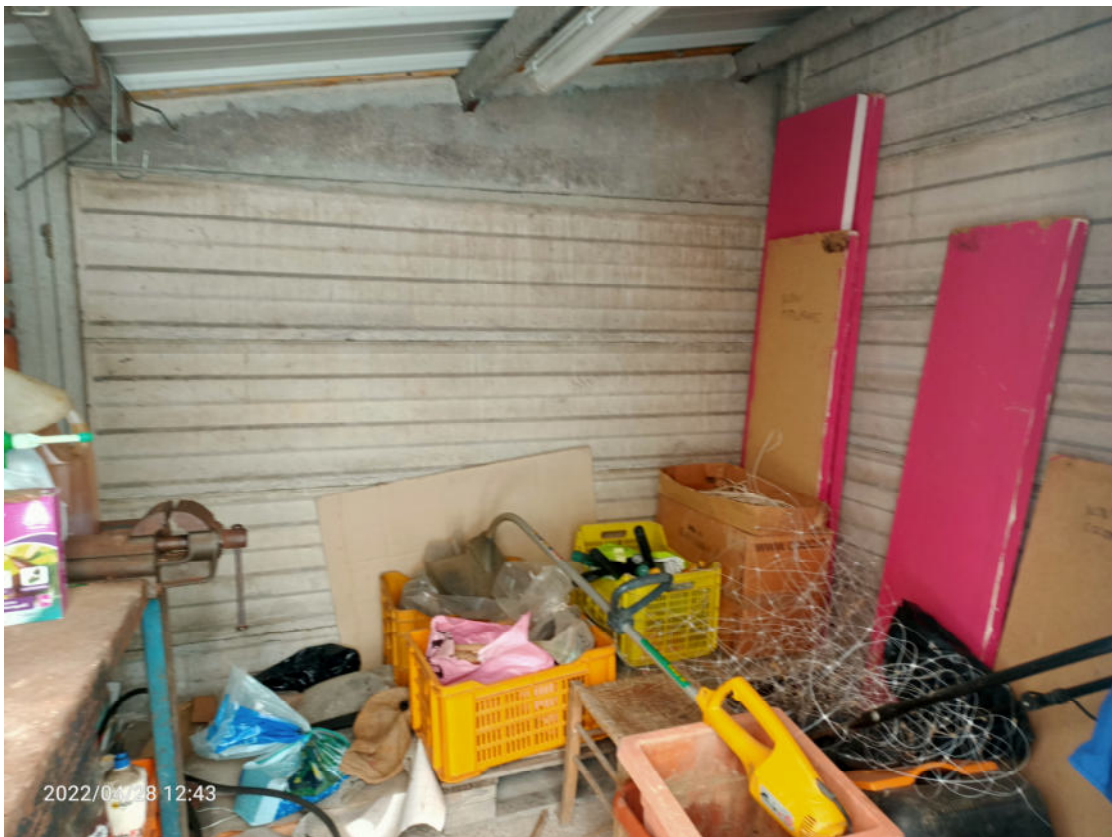
Comune di Porto Sant'Elpidio, Foglio 2 Particella 57 sub 3 magazzino/garage
