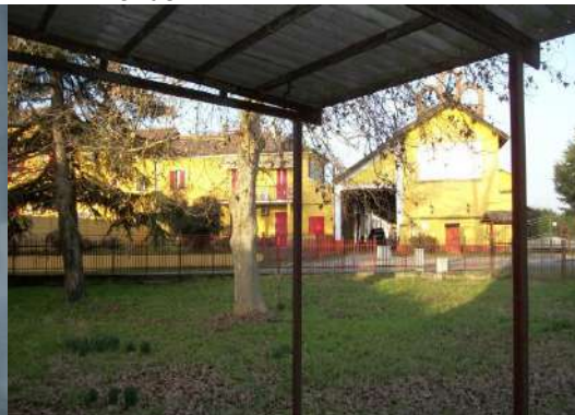
f.23 vista sotto tettoia edificio C
