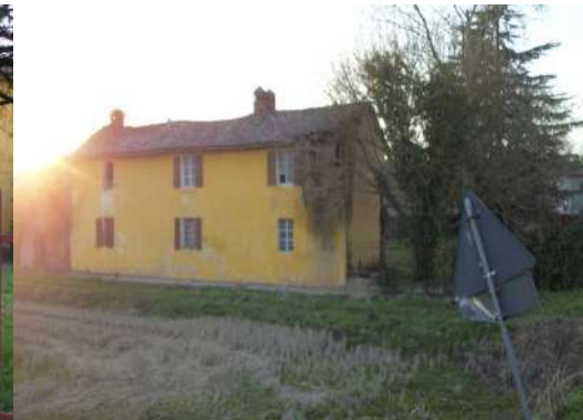
f.4 vista edificio A dalla via Roma
