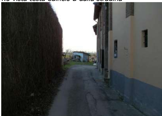
f.9 vista edificio B dalla stradina
