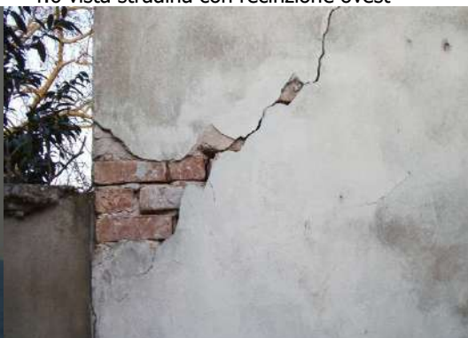
f.10 vista dissesto angolo muratura edificio C su stradina
