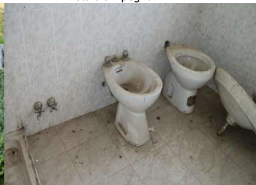
f.31 vista bagno
