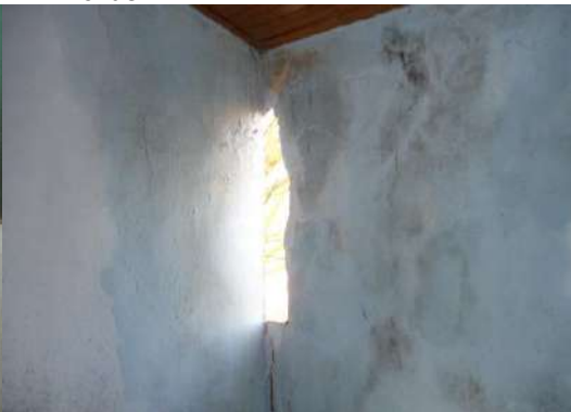
f.22 vista breccia aperta spigolo nord
