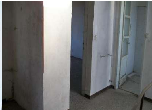
f. 27 vista disimpegno
