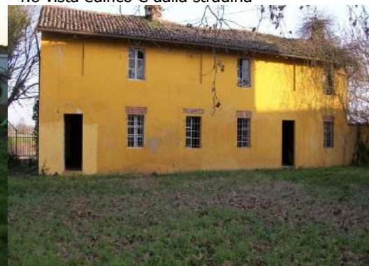
f.12 vista edificio A dal cortile
