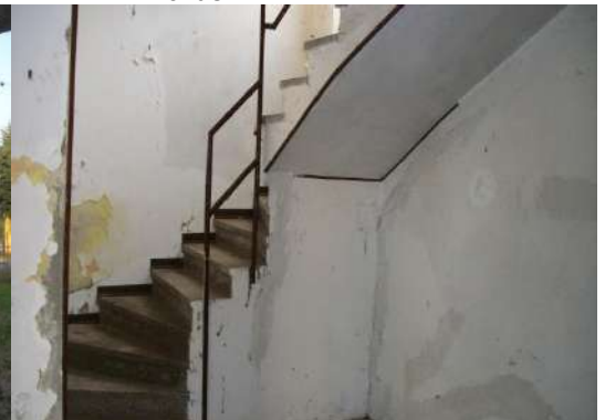
f.24 vista vano scala edificio C
