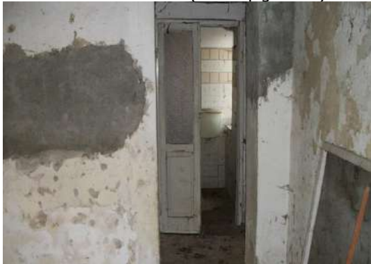
f.17 vista interno edificio A
