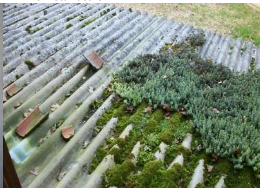
f.30 vista manto eternit tettoia
