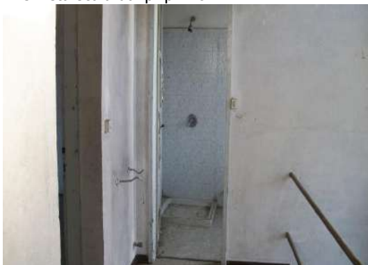
f.29 vista ingresso bagno
