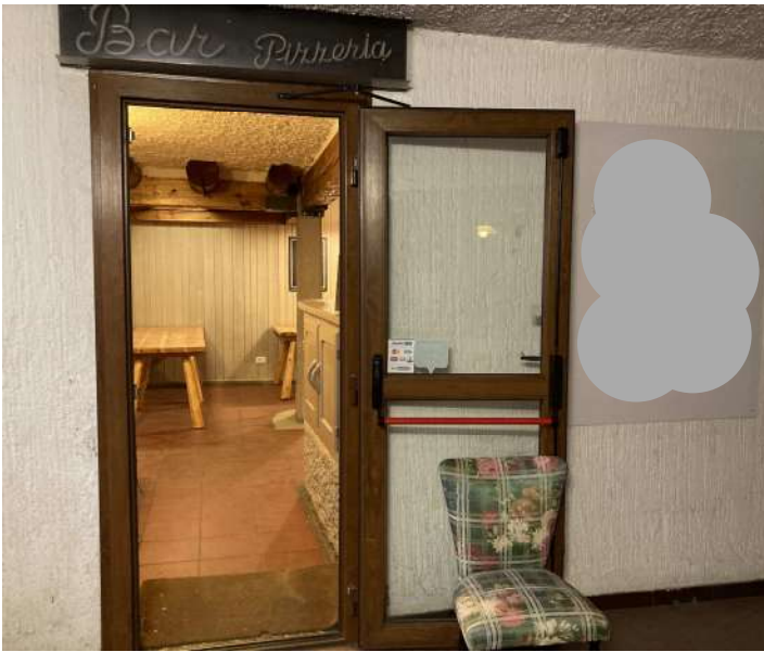
Foto 7: Porta accesso al Sub. 548
