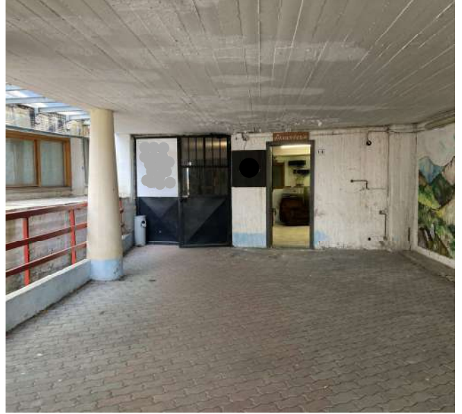
Foto 2: Porticato di accesso ai locali: a sinistra la porta di accesso all'ingresso, a destra la porta di accesso al sub. 615
