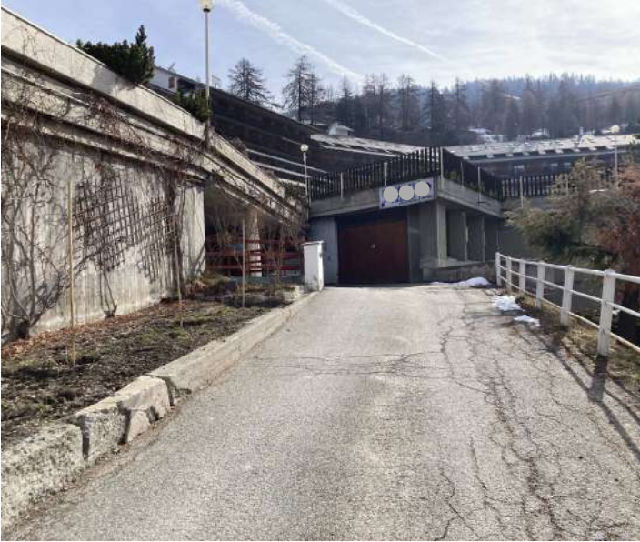
Foto 1: Rampa di accesso al piano primo sotterraneo del complesso.
