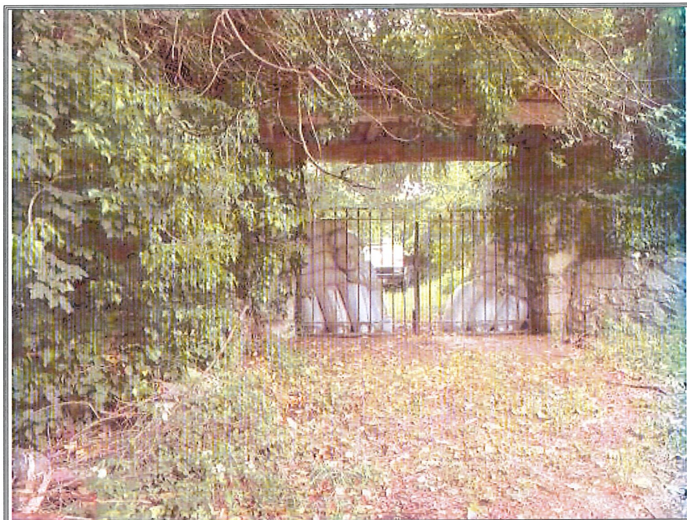
Foto n. 33 LOTTO N. 2 Accesso alla corte del fabbricato in Località Casenuove – Voc. Spiazza
