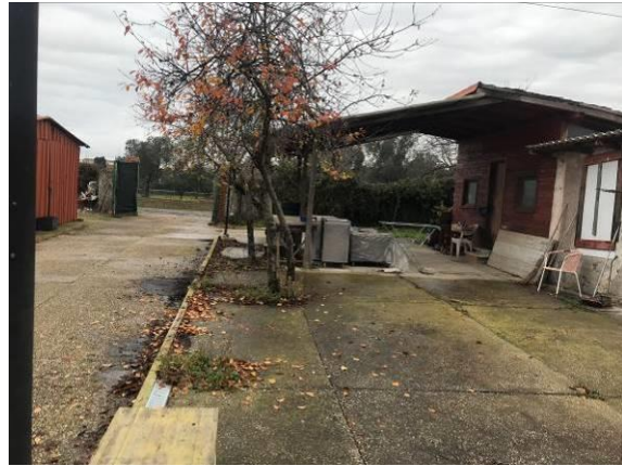
Parte del piazzale tra gli immobili
