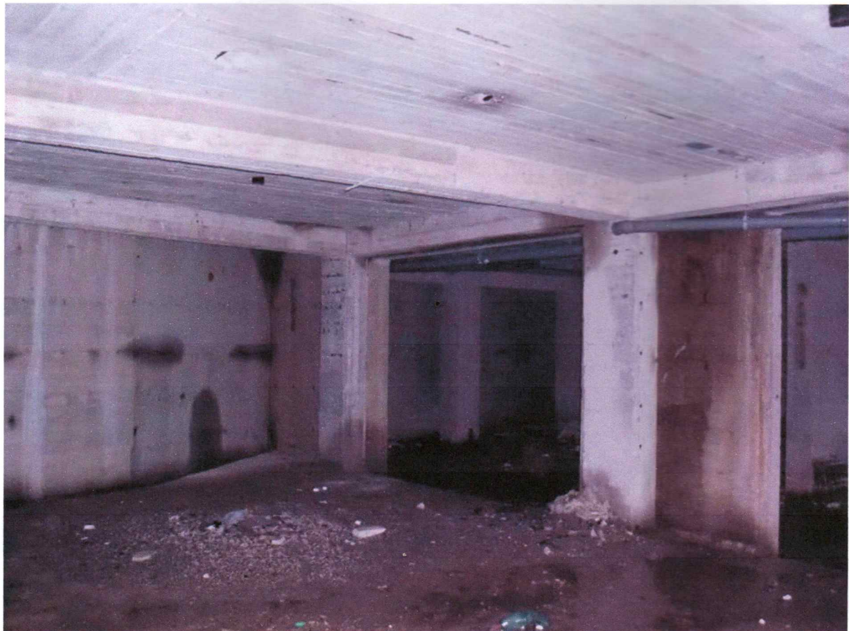
Vista dell'accesso al box auto
