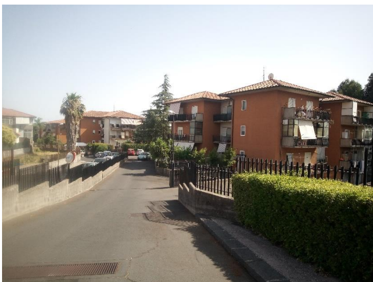
Foto 1) condominio sito in Mascalucia, via Tremestieri n°16 B, ove al secondo piano della palazzina B è situata l'unità immobiliare oggetto di esecuzione.
