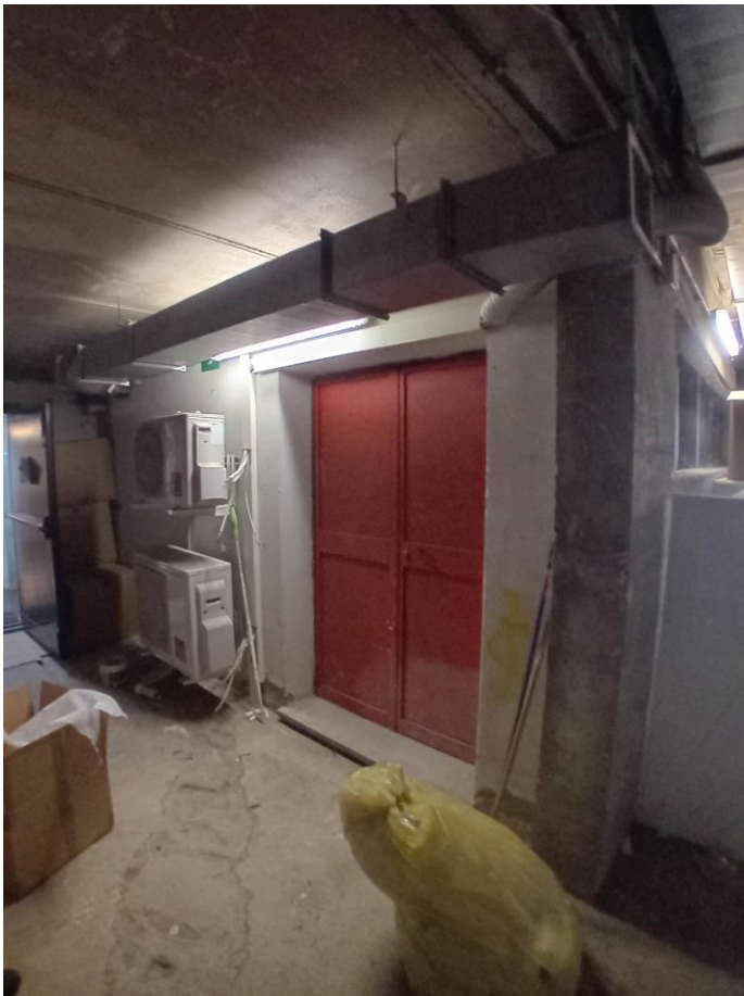
tubazioni della ventilazione da spostare
