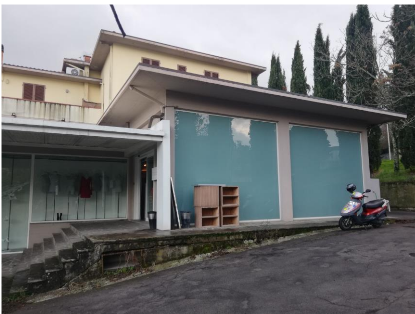
VISTA DA PIAZZALE ALTO
