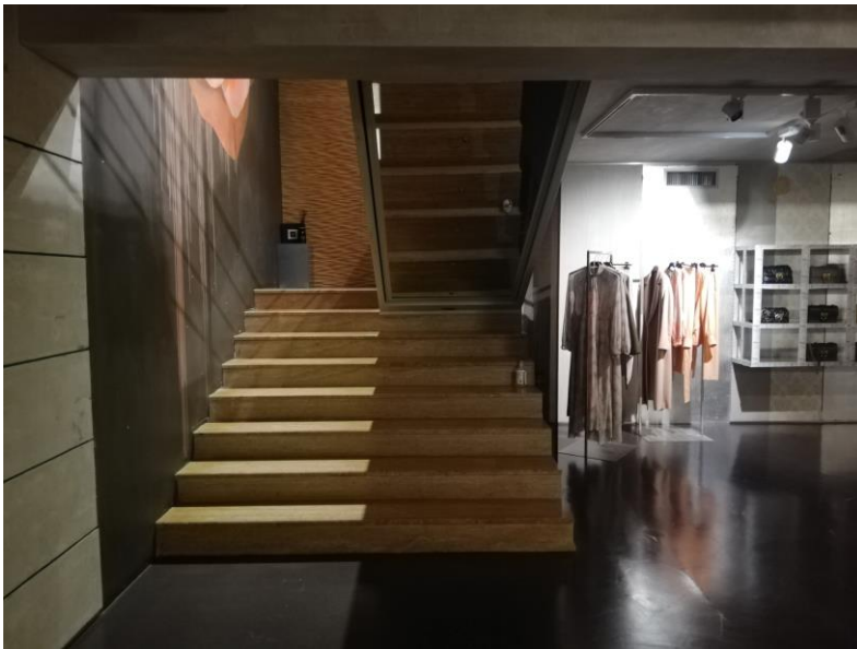
Particolare della scala a due rampe con vetrata di protezione laterale
