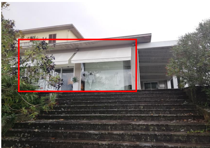
VISTA DAL MARCIAPIEDE
