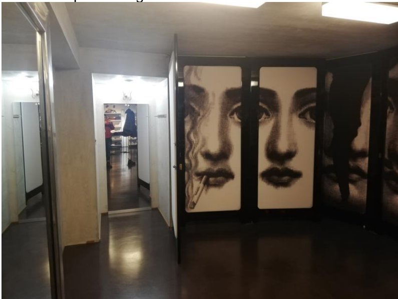
Locale negozio (2) con pavimentazioni in resina ed impianti di illuminazione esterni su canaline Le travature in cemento armato sono a vista e ricalate in quasi tutti gli ambienti
