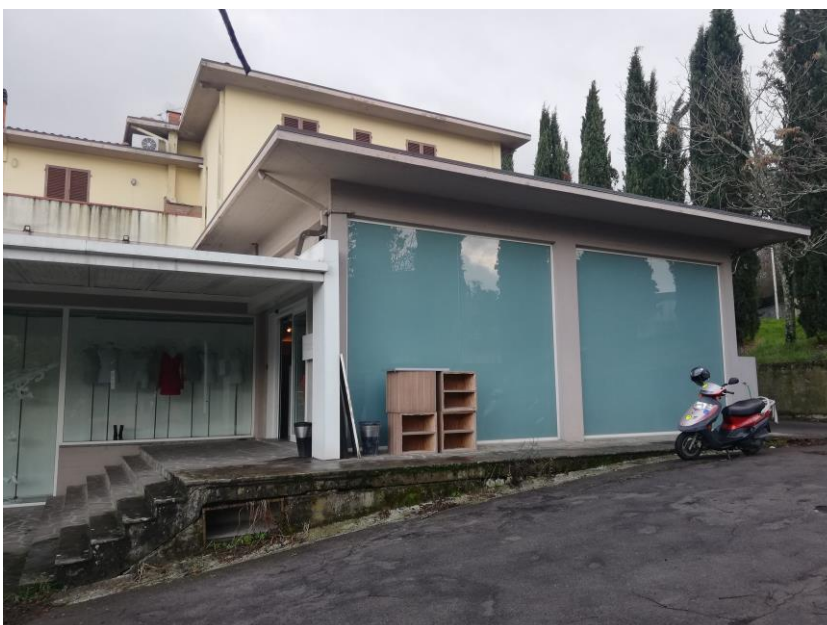
VISTA DA PIAZZALE ALTO
