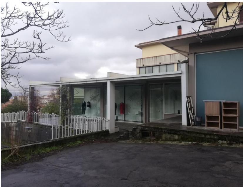
VISTA DA PIAZZALE ALTO
