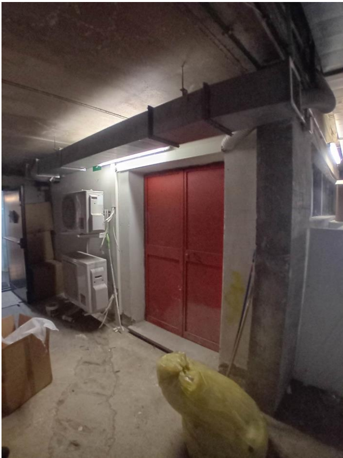
tubazioni della ventilazione da spostare
